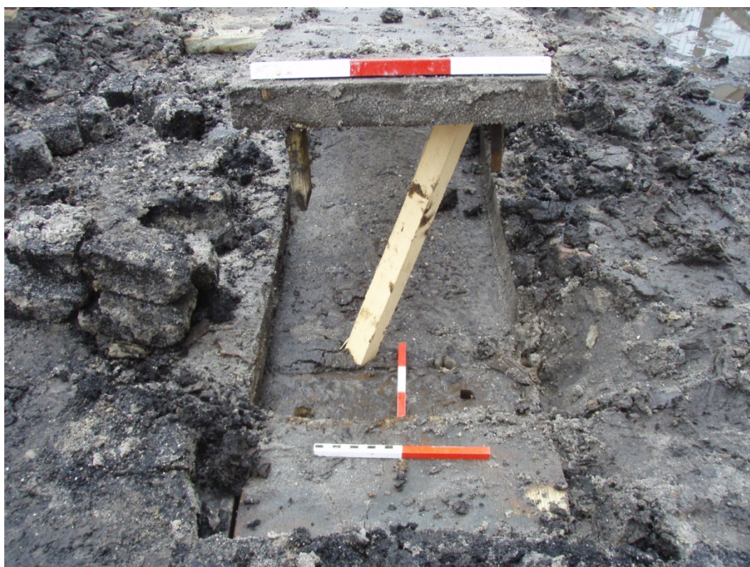
Afb. 13. Detail van de funderingswijze van de kosterwoning. Door middel van een piketpaaltje is de funderingsplank opgelicht om de pengat verbindingen zichtbaar te maken.
