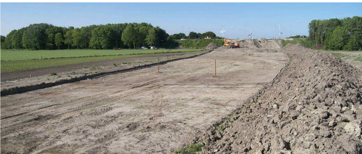
Afbeelding 41: het spoor van de ringgracht ter plaatse van de aansluitingsweg. Op de voorgrond is ook nog een donkere baan zichtbaar. Tussen deze baan en de gracht en ook in de gracht, zijn links op de foto orangerode puinsporen zichtbaar. Foto gezien vanuit het oosten; WAD.
