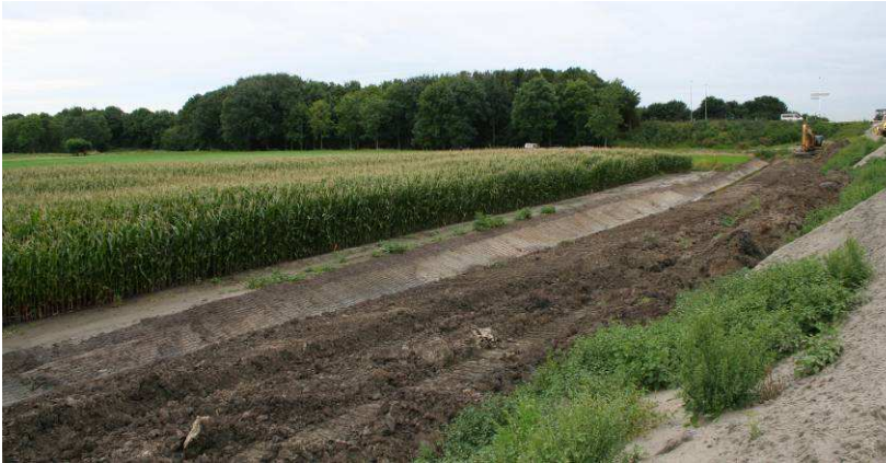
Afbeelding 106: zicht op het zuidprofiel van de bermsloot, die gegraven is ten zuiden van de proefsleuf, die is aangelegd ter plekke van de strook omgewoelde grond. Beide grachten zijn als donkergrijze stukken zichtbaar (vooraan en helemaal achteraan in het slootprofiel). Het tussengelegen heuvellichaam tekent zich lichtgrijs/ lichtbruin af. Foto gezien vanuit het noordoosten. Foto WAD.
