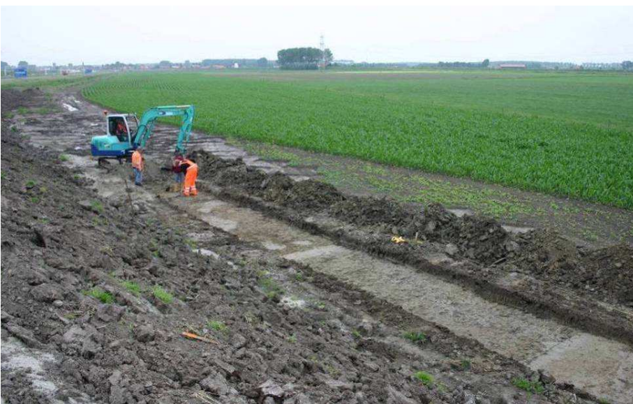
Afbeelding 56: aanleg van vlak 1 ca. 48-70 m, de donkere baan is de restvulling van het noordoostelijke deel van de ringgracht (spoor 10). De gracht strekt zich verder in zuidwestelijke richting uit. Foto gezien vanuit het noordwesten, met links op de achtergrond de A58. Foto MK.
