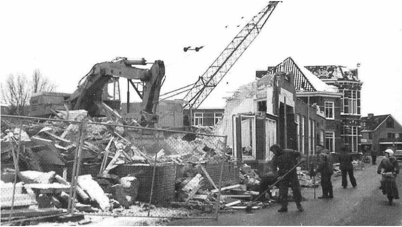
Afb. 6.7. De afbraak van het gebouw van de Johannes Stichting (N. Habermehl, 2013, 224).
