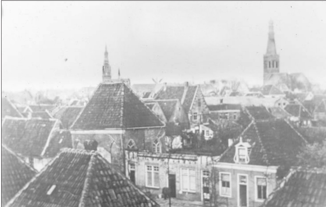
23. Panorama van Medemblik uit 1925. Links de synagoge, en rechts daarvan het dubbele pand en een woonhuis op de onderzoekslocatie Gedempt Achterom 45.
