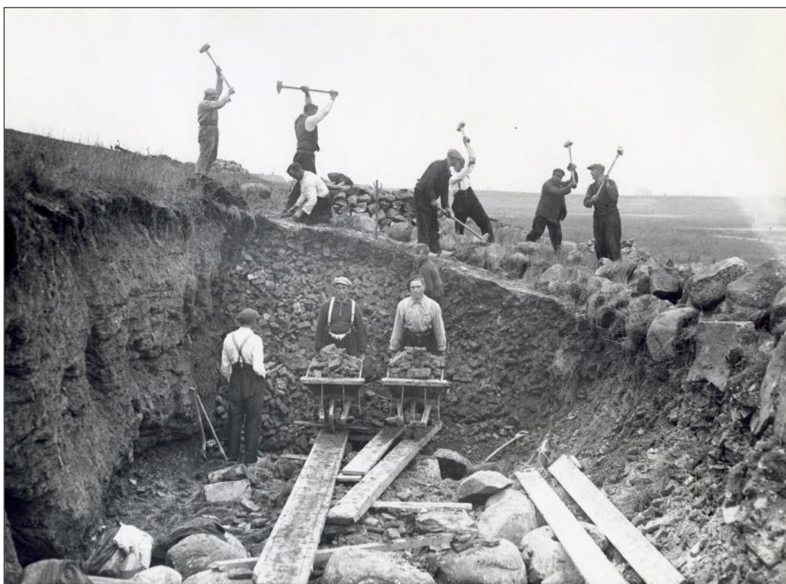
16. Het afgraven van de zeedijk in 1935 (collectie NA).
