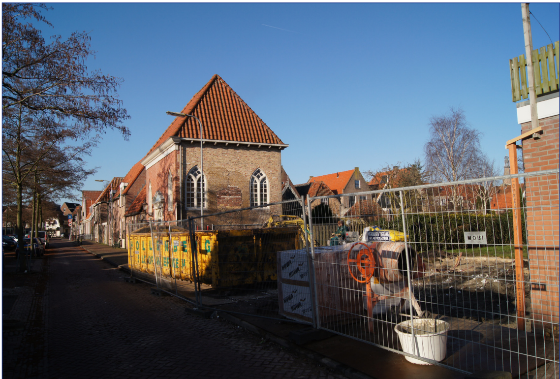
27. De opgravingslocatie na sloop van de panden in het voorjaar van 2012
