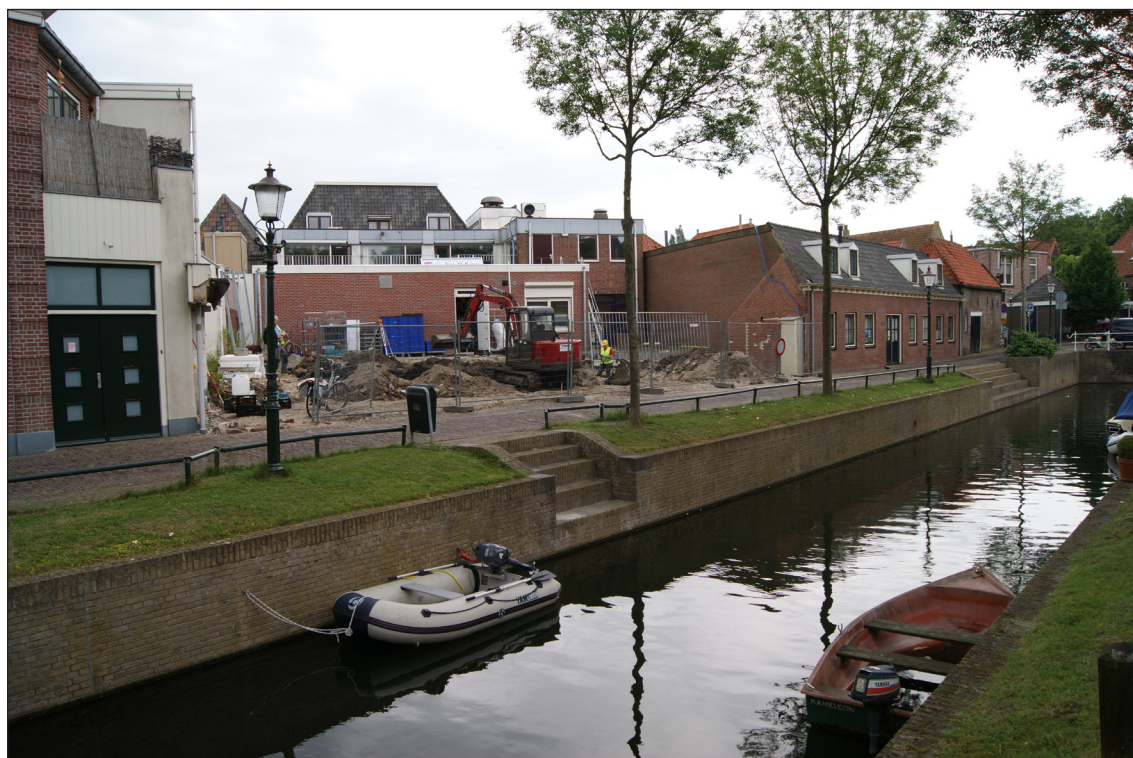
32. De onderzoekslocatie Achterom 14 in 2011.
