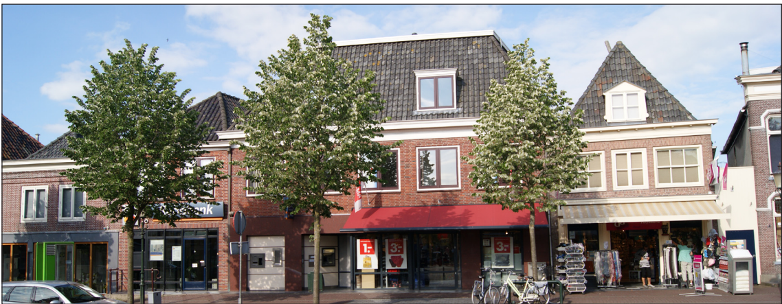
30. Nieuwstraat 78, 76, 74 en 72 in 1962 en 2011. De onderzoekslocatie ligt achter de panden van de Hema (Nieuwstraat 74) aan het Achterom.
