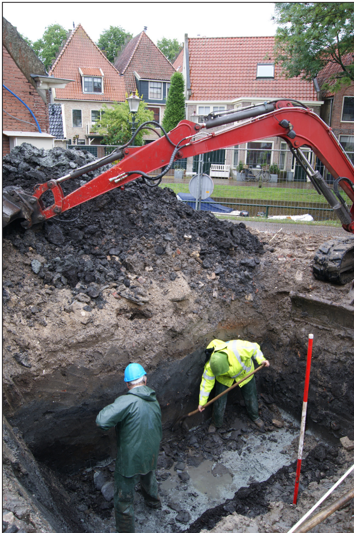
35. Aanleg profiel (bijlage 4 nr. 3) vak 1 werkput 2.
