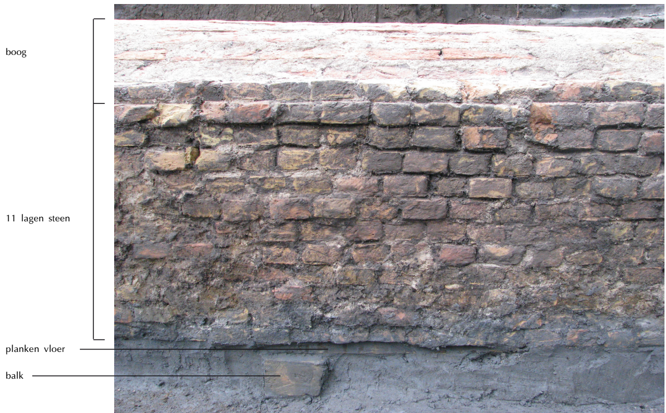
Afbeelding 31. Detailopname van de duiker.
