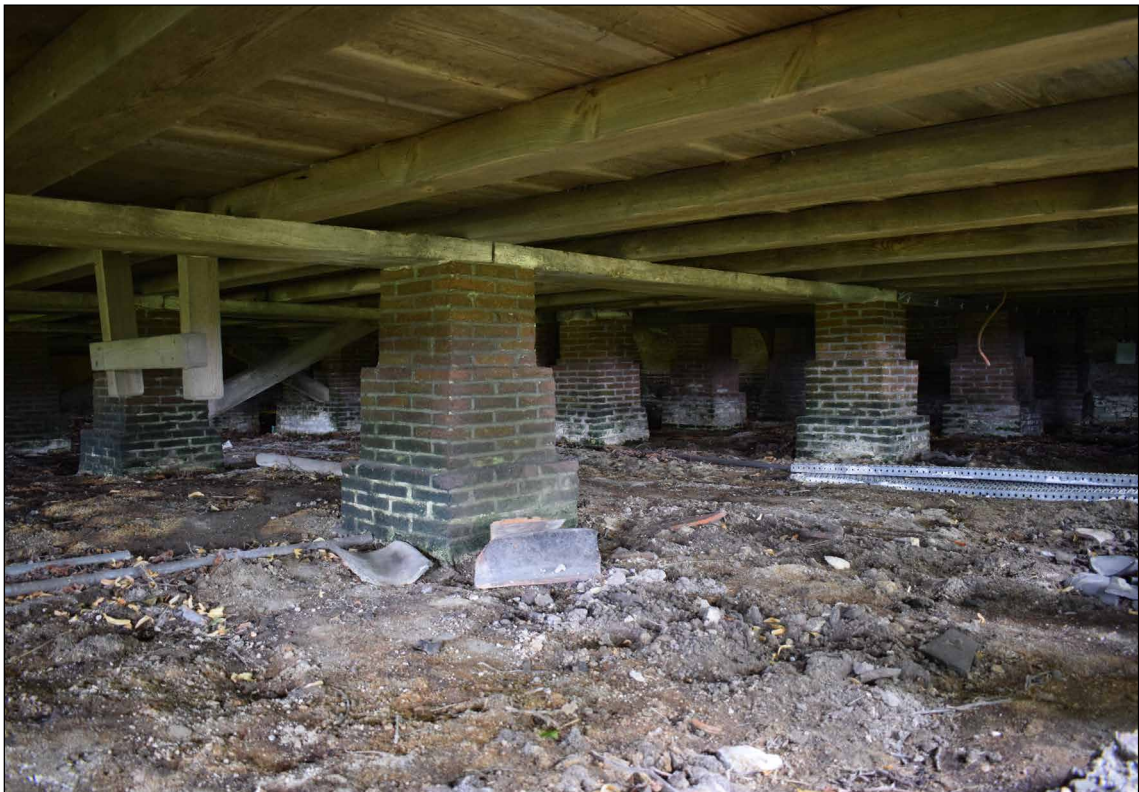
Afb. 72 De Zuidervermaning in Westzaam is gebouwd op bakstenen poeren.
