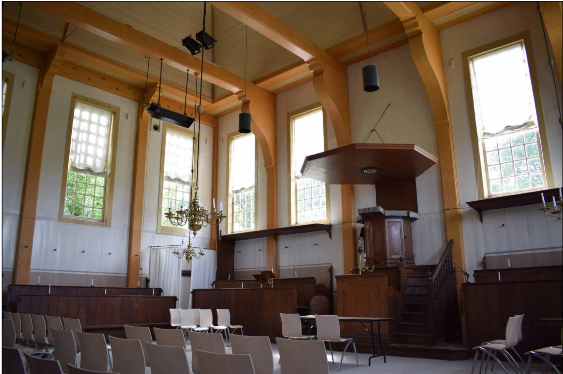
Afb. 71 Interieur van de Zuidervermaning in Westzaam. De ruimte wordt overspannen door lange balken die steunen op zwanehalskorbelen.
