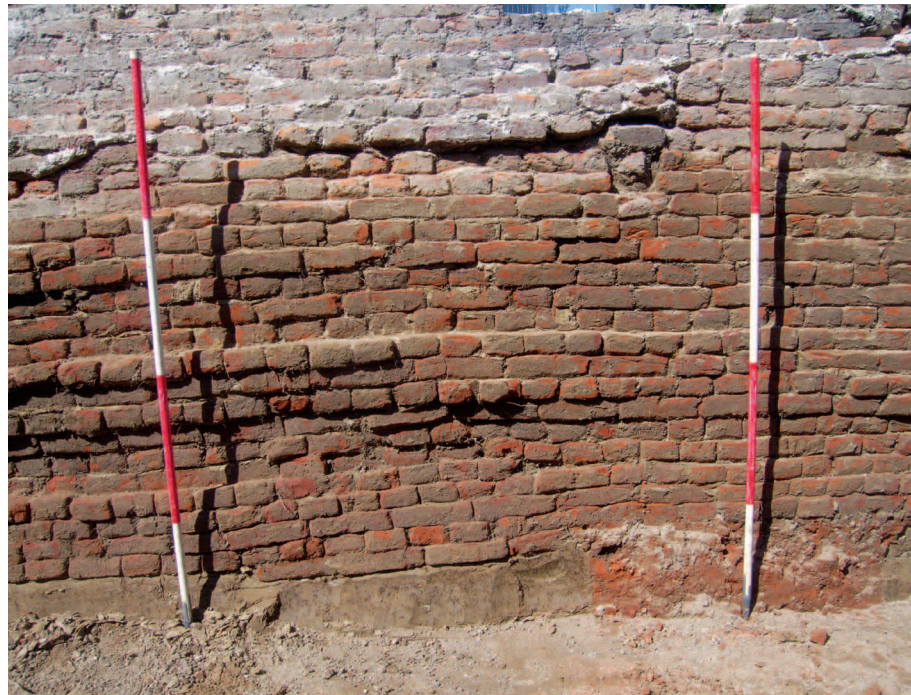
Afbeelding 3.9 Detail van het metselwerk. Duidelijk zijn de stroken in het metselwerk te zien.
