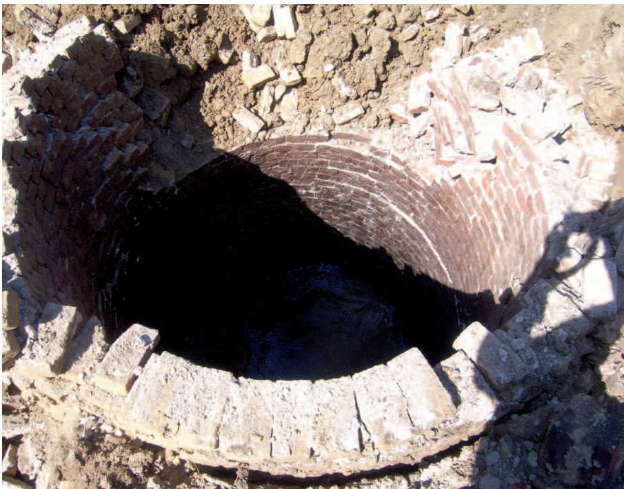
Afbeelding 3.33 De put na verwijdering van de koepel.
