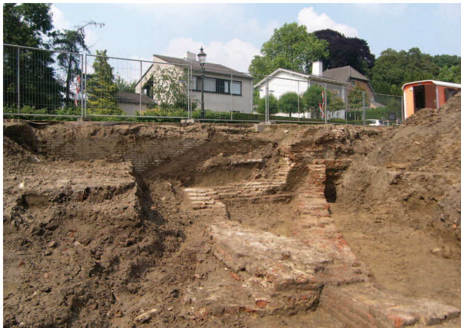
Afbeelding 3.19 Overzicht van de rechtgetrokken hoek (S4018) vanuit het zuiden gezien.
