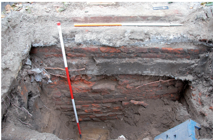
Figuur 6. Stadsmuur in WP2 S30 onder betonnen voet van de tuinmuur.
