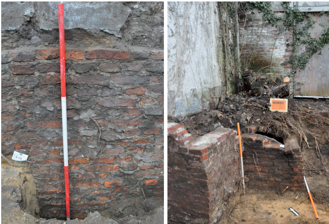
Figuur 26. Achtergevel met aanzet van inpandige kelder. Rechts later aangebouwde (water)kelders.
