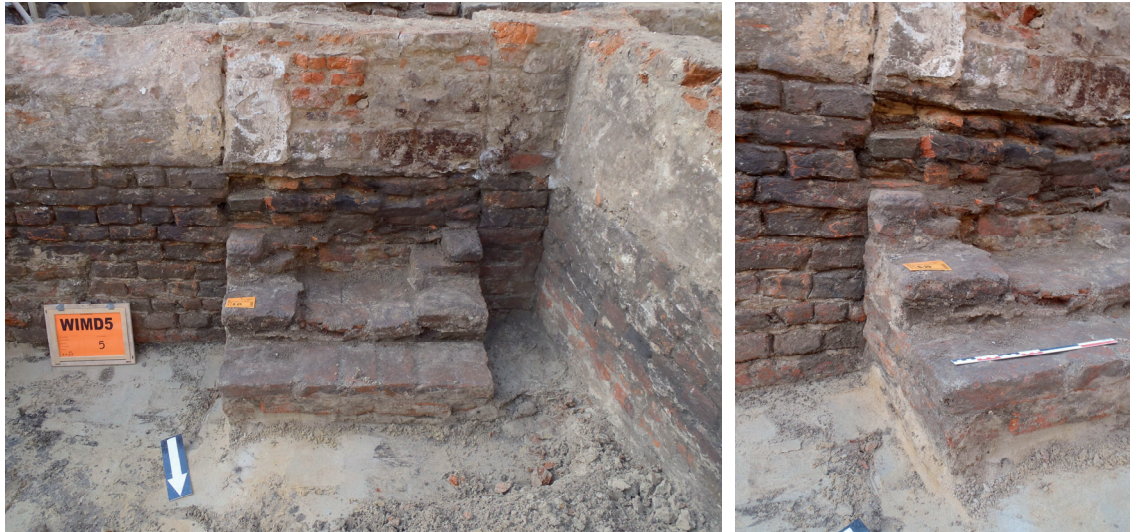
Figuur 18. Opening met mogelijke trap S29. Rechts detail van het voor de muur geplaatste blok.
