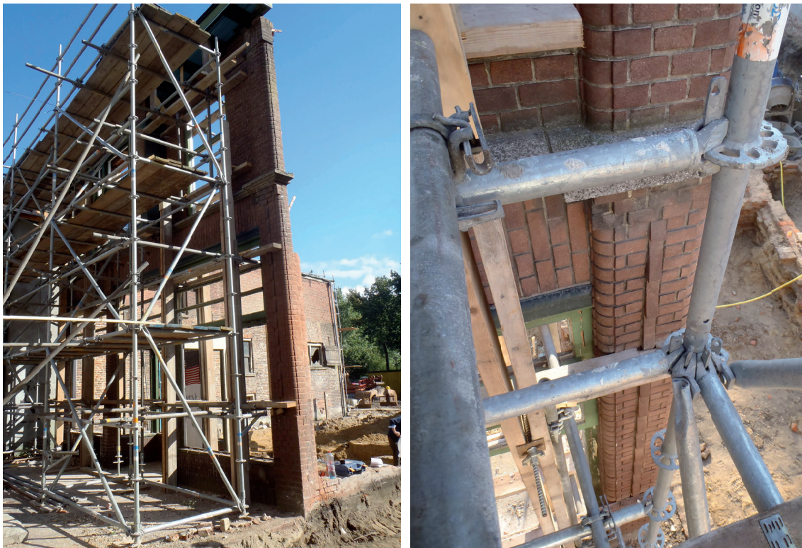
Figuur 11. Gevel uit de jaren '30 van de 20e eeuw: veel baksteen met rondingen en versieringen.
