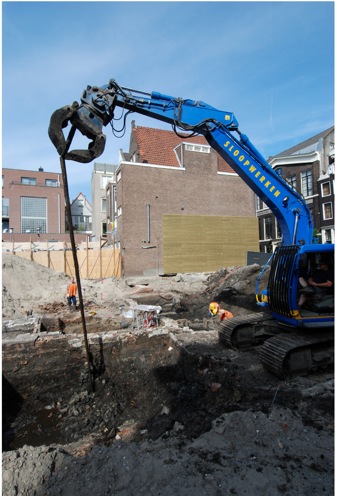
46 De dendrochronologische datering van een 9 m lange funderingspaal onder de bebouwing op het achterterrein van Elandsstraat 101 leverde een bouwjaar op van na 1736
