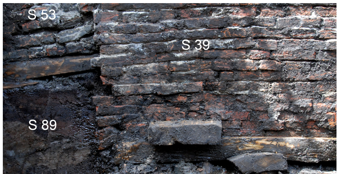
22 De doorgang naar het binnenplaatsje achter 103-105 werd eenvoudigweg dichtgezet met een muurtje (S 53) tussen de zijgevel van 105 (S 39) en de bouwmuur van de achterbouw S 18 (niet zichtbaar)
