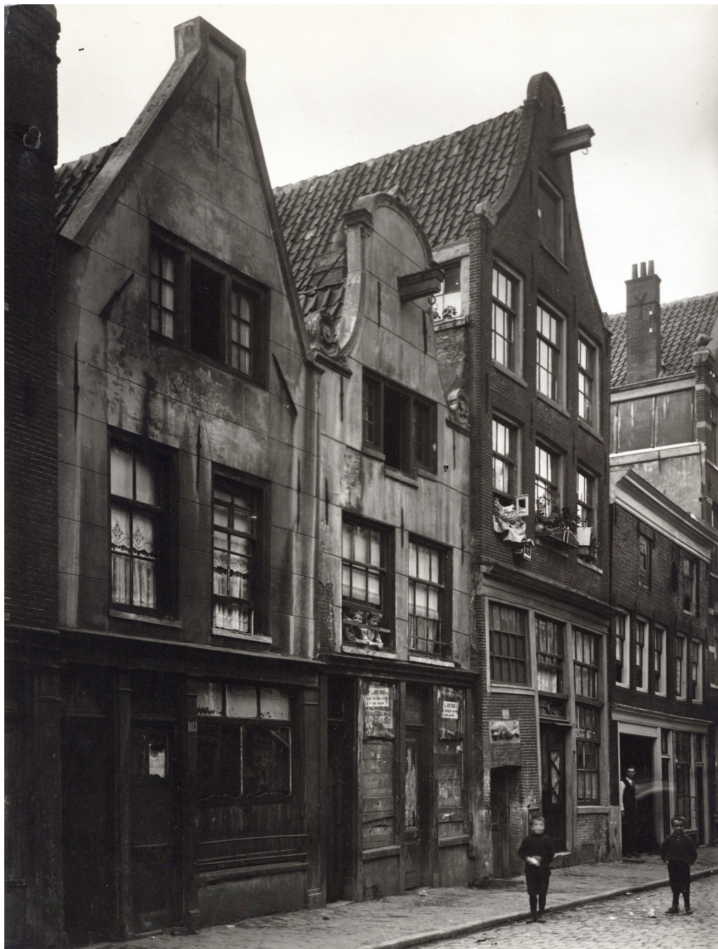
7 Elandsstraat 103, 105-109, met de gevelsteen D' Vergulde Dolfijn boven het poortje van de Dolfijnengang. Situatie in 1922, voorafgaande aan de sloop in 1929 (Stadsarchief Amsterdam)
