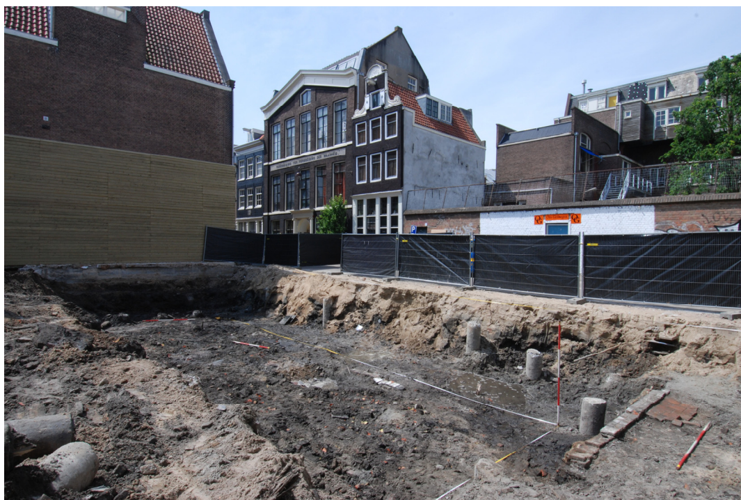
47 Werkput 1 langs de Elandsstraat. Voorafgaande aan de nieuwbouw in 1980 is de fundering van de oorspronkelijke bebouwing langs de straat vrijwel volledig verwijderd
