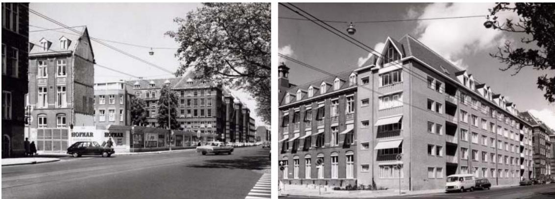
9 Gebouw St. Bernardus gezien vanaf de Marnixstraat. Links in juni 1970 met een bouwput langs de straat, rechts de nieuwe vleugel (situatie jaren 1970-1971)(Stadsarchief Amsterdam )
