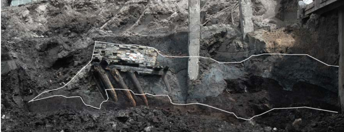
11 Doorsnede van de overblijfselen van de vestingwal op het Marnixplein uit 1613 (witte lijn). Door de druk van het wallichaam is de schildmuur uit het rampjaar 1672 richting de gracht (naar links) weggedrukt
