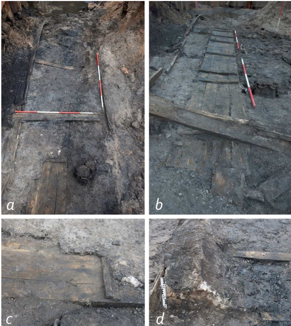
13 a Het raamwerk (S 5 en S 10) waarbinnen de betonnen goot (S 14) is aangelegd, b Het plankier (S 15) centraal in het raamwerk ontdaan van het beton, c Het beton ligt direct op het plankier, d Tegen de rechtopstaande planken van het raamwerk zijn de olopande randen van de betonnen goot gevormd.
