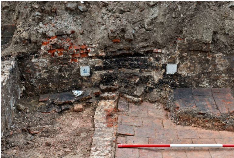
30 In de zuidelijke ruimte van Valkenburgerstraat 104 werd bij de vergroting van de kelder aan de straatzijde tot muur S 113 (geheel links) tegen de oostmuur, op de plek van de oude gesloopte binnenmuur S 114 (midden) een haard (S 119) gerealiseerd, de plavuizenvloer rechtsonder (S 116) behoort tot de oudste fase, de net zoals de haard beroete plavuizenvloer rechtsboven (S 118) behoorde tot de tweede fase en sloot aan op de haard
