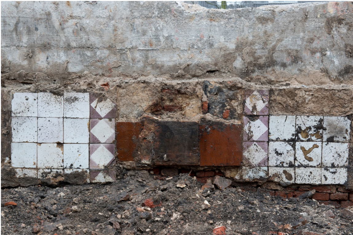
24 Tussenmuur met restanten van de haard in de 18de-eeuwse bebouwing op Valkenburgerstraat 102A, gezien naar het noorden. De muur werd afgedekt door de betonnen fundering uit de jaren 1930
