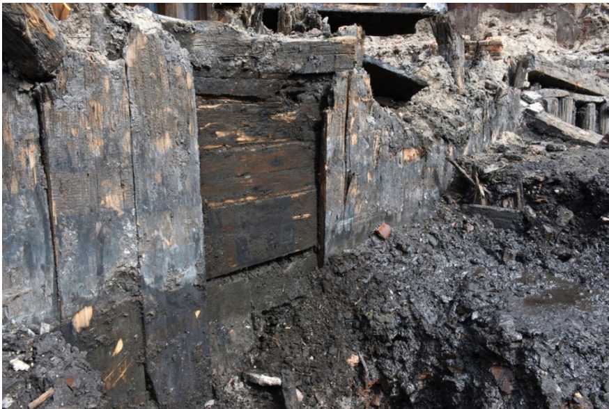
21 Detail van de noordwand van caisson S 202 waarop de dubbele laag van planken te zien is
