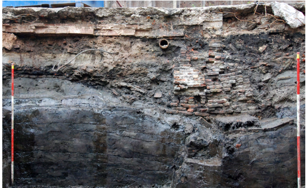
12 Noordprofiel (profiel 4) in werkput 1. Goed zichtbaar is hoe de zijgevels van Oudezijds Armsteeg 14 en 20 zijn verzakt
