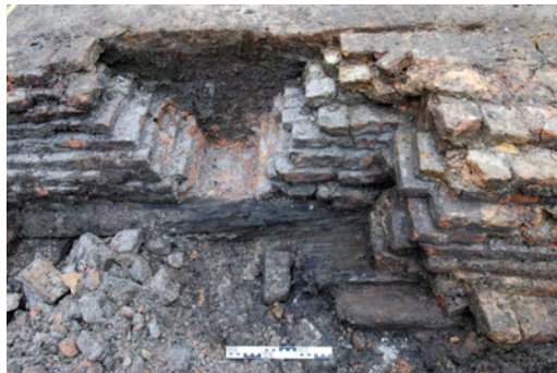
17 Oudezijds Armsteeg 12, met de inpandige kelderbak (S 43) gezien richting oosten met daar omheen de muren S 51 en S 49 en op de achtergrond waterkelder S 50: rechtsonder de zuidelijke buitenmuur van nr 12 (S 49) die gedeeltelijk op langshout rustte en voor een ander deel op de versnijdingen van de muur rondom de kelderbak (S 51)
