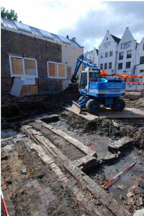
22 Overzicht van werkput 1, vlak 1, gezien richting Oudezijds Voorburgwal 28 (linksachter) en de achterzijde van de bebouwing aan de Warmoesstraat (rechtsachter). Links loopt de 17de-eeuwse westelijke zijmuur van Oudezijds Armsteeg 20. Rechts daarnaast is een deel van het achterhuis van nr 14 uit omstreeks 1615 te zien met een deel van het voorhuis op de voorgrond. De smalle langwerpige ruimte in het achterhuis was mogelijk een inpandige gang. In het midden de tussenmuur met een doorgang met een traprede
