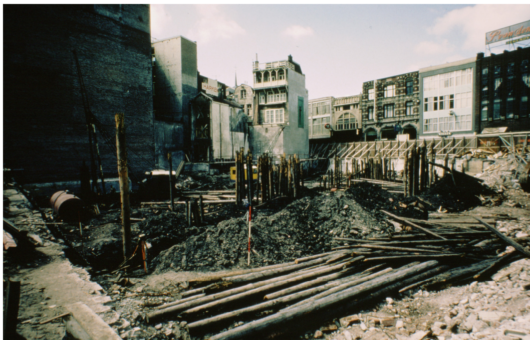
7 Bouwput C&A in 1964, gezien richting de Nieuwendijk
