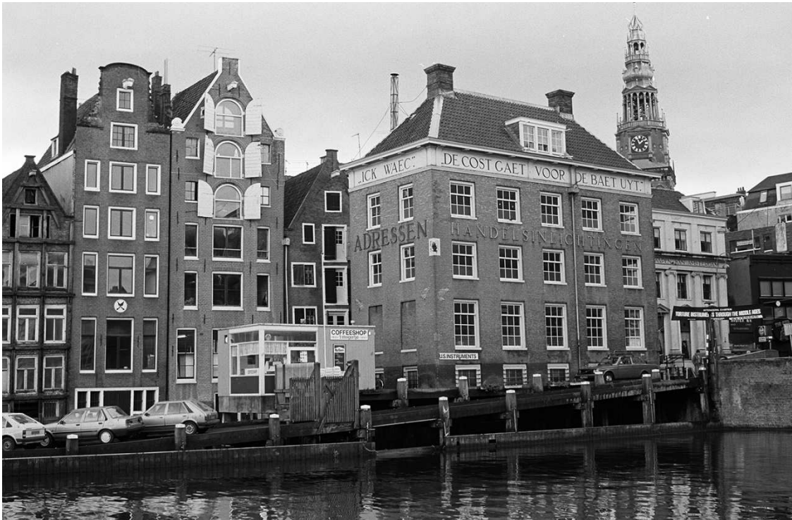
6 De situatie in 1985. De steiger wordt gebruikt als parkeerplaats. In de keet zit coffeeshop 't Steigertje. Het is deze versie van de steiger die in november 2017 werd verwijderd (Stadsarchief, beeldbank BMA00004,000038_004)
