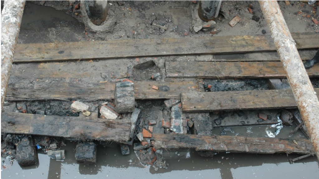
14 Afdekt en afgesneden restant van een gewelfd riool, onder de planken vloerfundering van de jongere fase van de gemetselde kademuur
