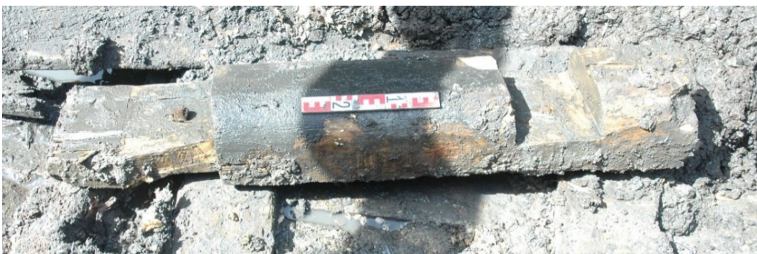
8 Gording met zwaluwstaartinkeringen en houten nagels ter bevestiging aan de onderliggende leggers
