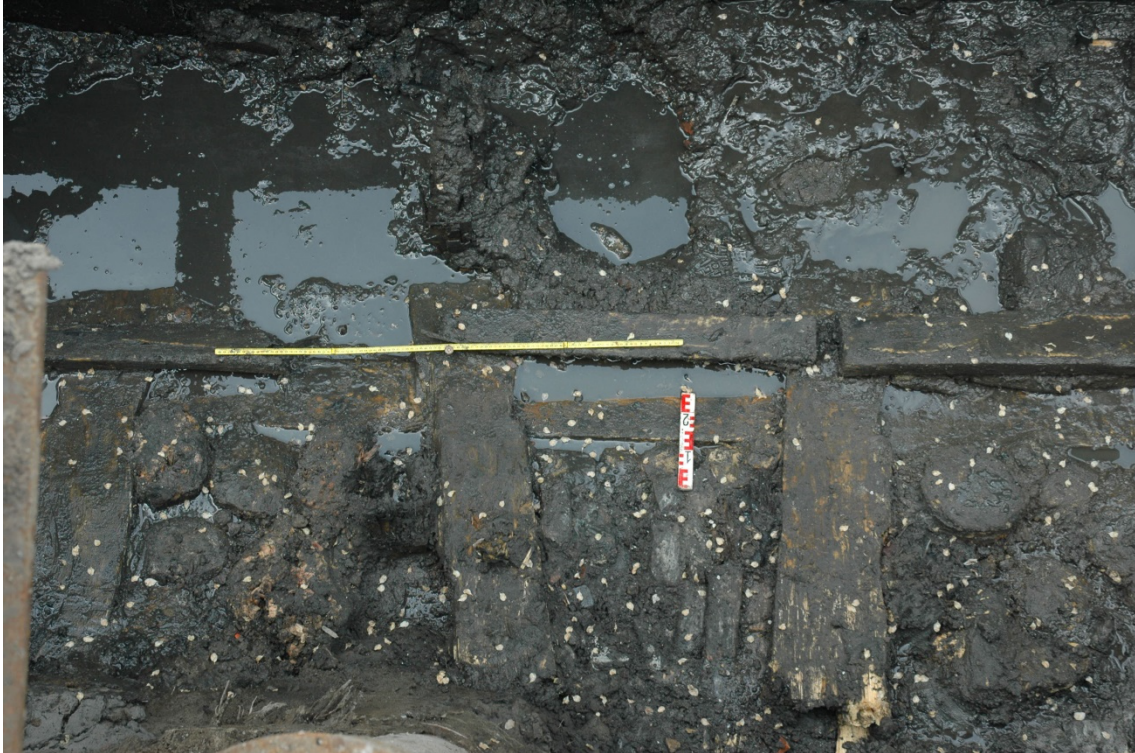
9 Detail van de roosterfundering met deels houten ingeslagen slieten en deels baksteenvulling binnen de vakken
