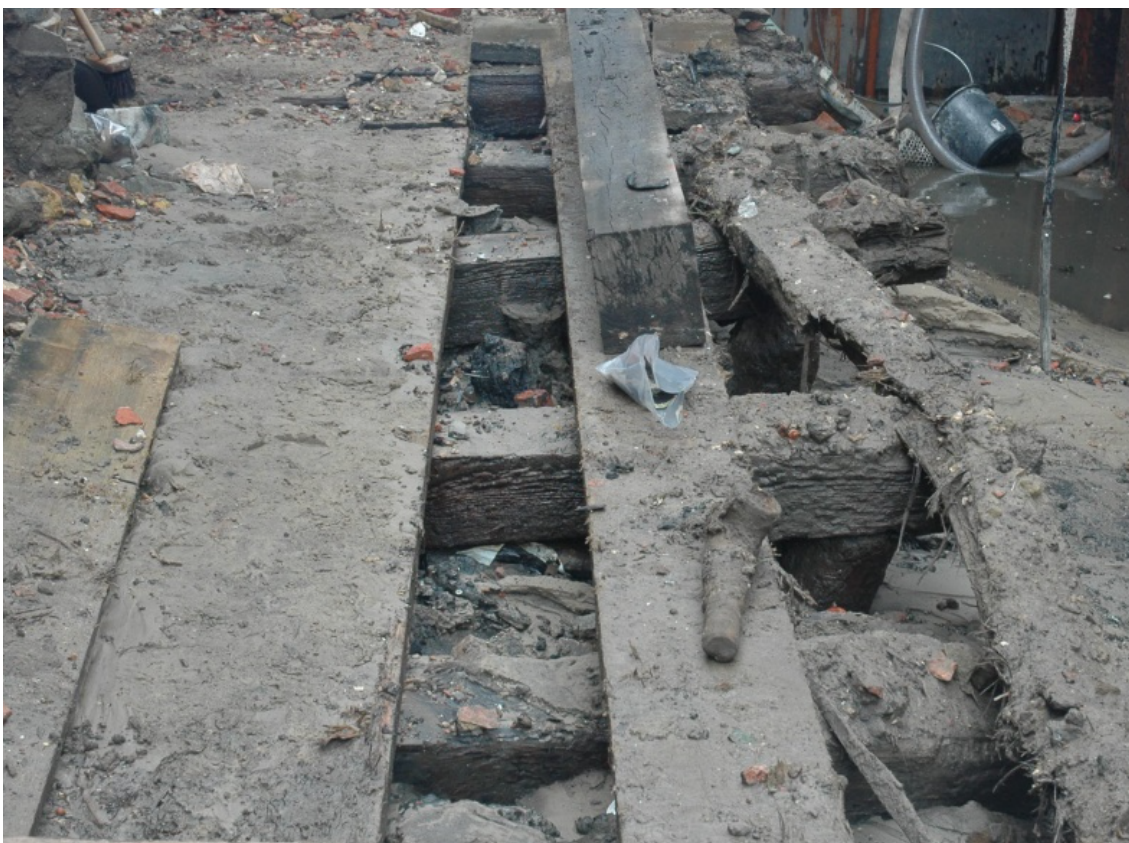
18 Masten (rechts) onder de kespen, waarop de planken funderingsvloer is aangelegd
