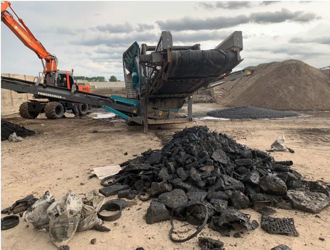
3 De mobiele zeefinstallatie met 3 maaswijdtes. Op de voorgrond de grove fractie (> 4 cm), met zeer veel bouwpuin
