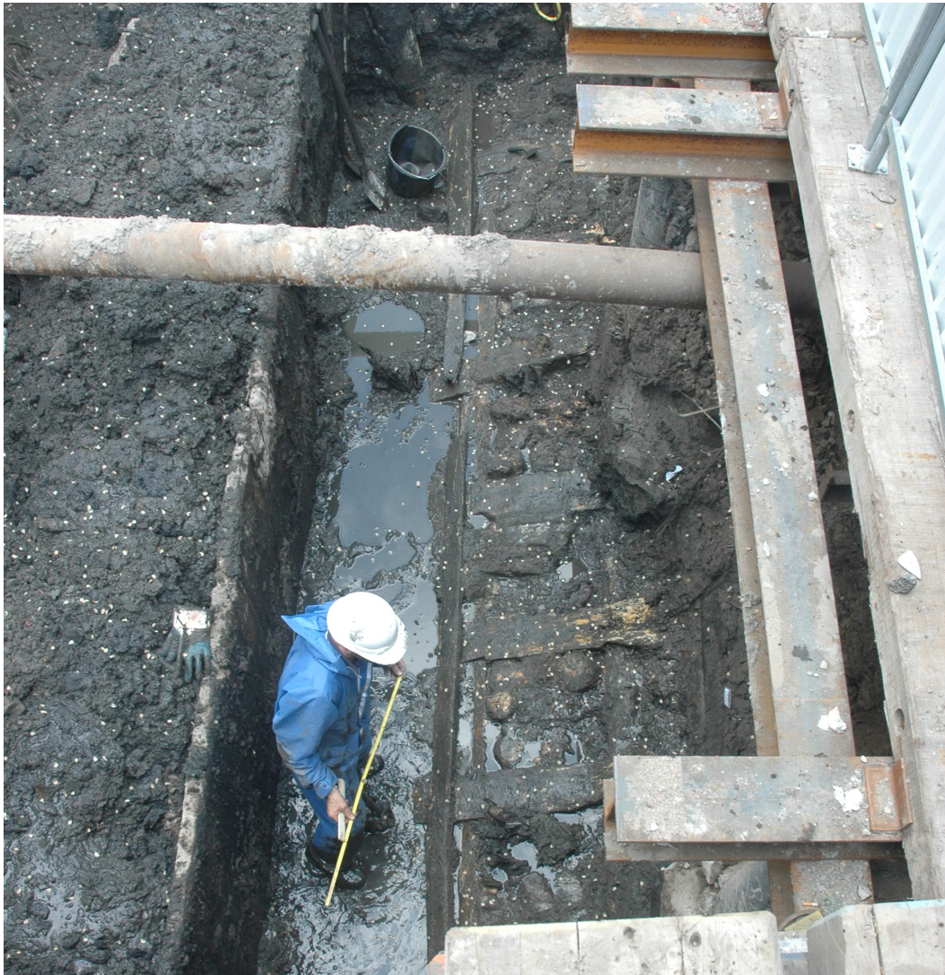
7 Restanten van een roosterfundering aangetroffen in een dieper ontgraven proefput. Links een 20ste-eeuwse damwand van houten planken, rechts metalen H-balken voor de diepwanden. Het ontgravingsniveau ligt op ca. NAP -2,10 m
