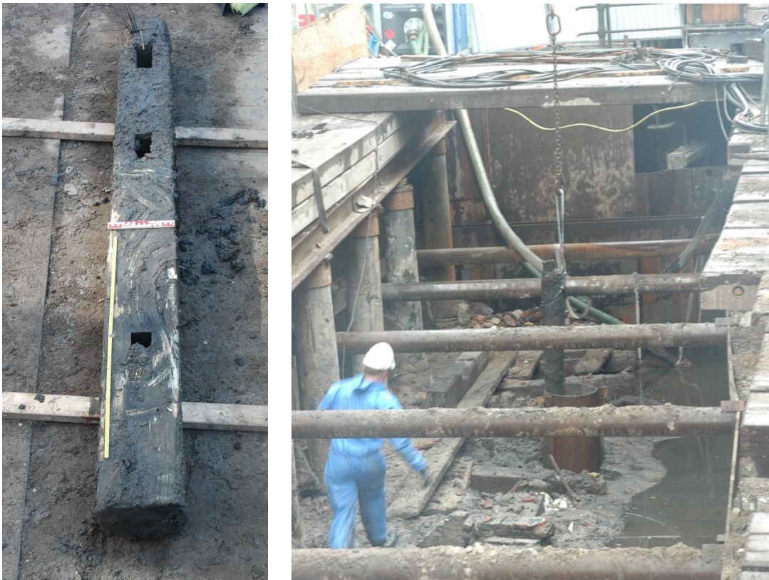
19 a (links): een van de kespren, met daarin de rechthoekige verbindingsgaten voor opname van de pen van de onderstaande masten. Boven is de waterkant van de kesp; b (rechts): voor het onderzoek naar de kwaliteit van de masten werd getracht enkele daarvan te bergen. Hierbij werd al snel duidelijk dat de houten palen schuin in de grond stonden, waardoor zij niet compleet uitgetrokken konden worden
