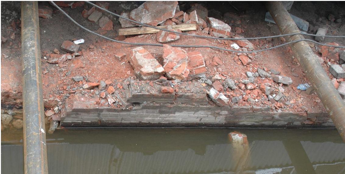
12 Een-steens klamp van roodbruine baksteen voor de walmuurnern van oranje-rode baksteen, tijdens de sloop van de kademuur
