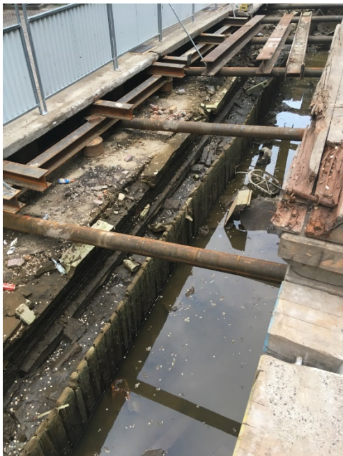
20 Damwand uit de 20ste eeuw van houten planken, middels messing en groef met elkaar verbonden
