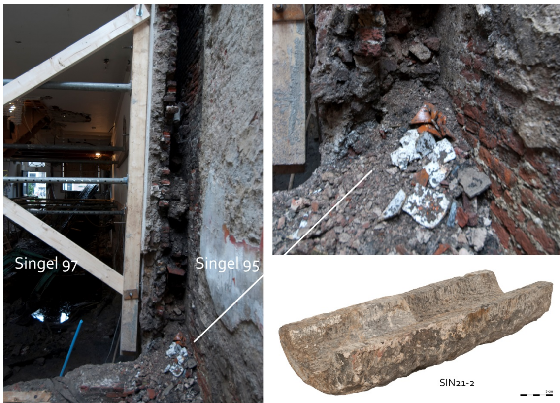
47 In de druijstroom of osendrop tussen Singel 97 en 95 lag een goot opgebouwd uit natuurstenen elementen (SIN21-2). De smalle ruimte tussen beide panden was gedeeltelijk volgestort met gruis, fijn bouwpuin en scherven (SIN21-1)
