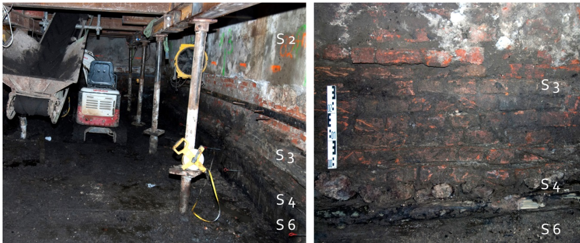
26 Links: de ontgraven ruimte gezien richting de voorgevel met het niveau van de hoofdsporen langs de linker zijgevel, rechts: de staalfundering van muurwerk S 3 was opgebouwd uit liggende stammetjes (S 4) gevleid in zand op de ophoging S 6
