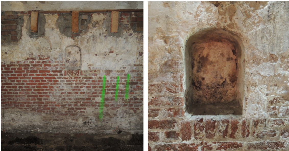
11 De rechterbouwmuur van de kelder (S 2) met een van de drie kaarsnissen en bovenin de restanten van de vloerbalken van de begane grond, rechts detail van een kaarsnis met de, voor Amsterdam typische, halfcirkelboog
