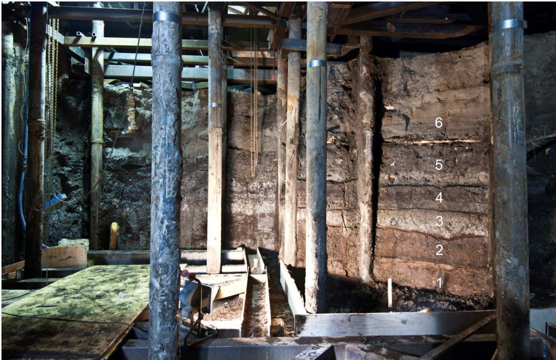
52 De westhoek in de bouwput waar het profiel werd gedocumenteerd
