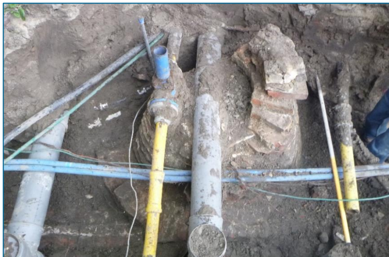
Afbeelding 102. Rioloput S388 in WP11, gefotografeerd richting het zuiden.
