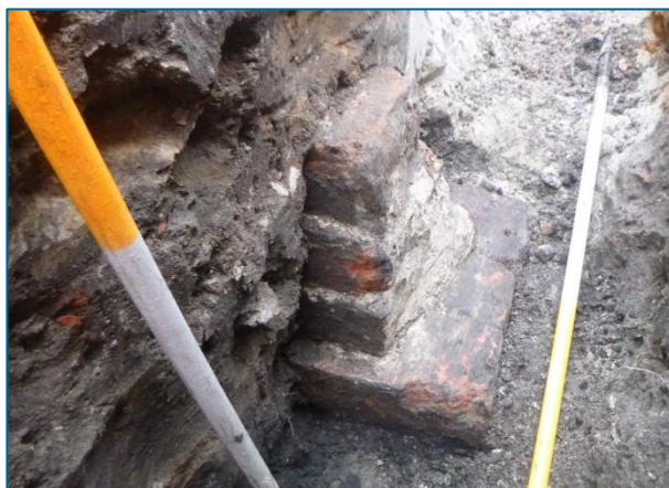
Afbeelding 58. Fundering S525 in de putwand van WP13-O, gefotografeerd richting het noorden.
