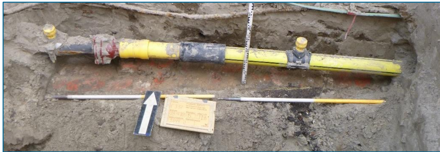
Afbeelding 71. Muurfundering S644 in WP15, gefotografeerd richting het noorden.
