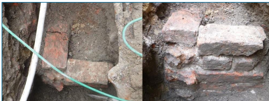
Afbeelding 79. Bovenaanzicht (links) en zijaanzicht (rechts) van fundering S571 in WP15. Het noorden ligt op beide foto's rechts.
