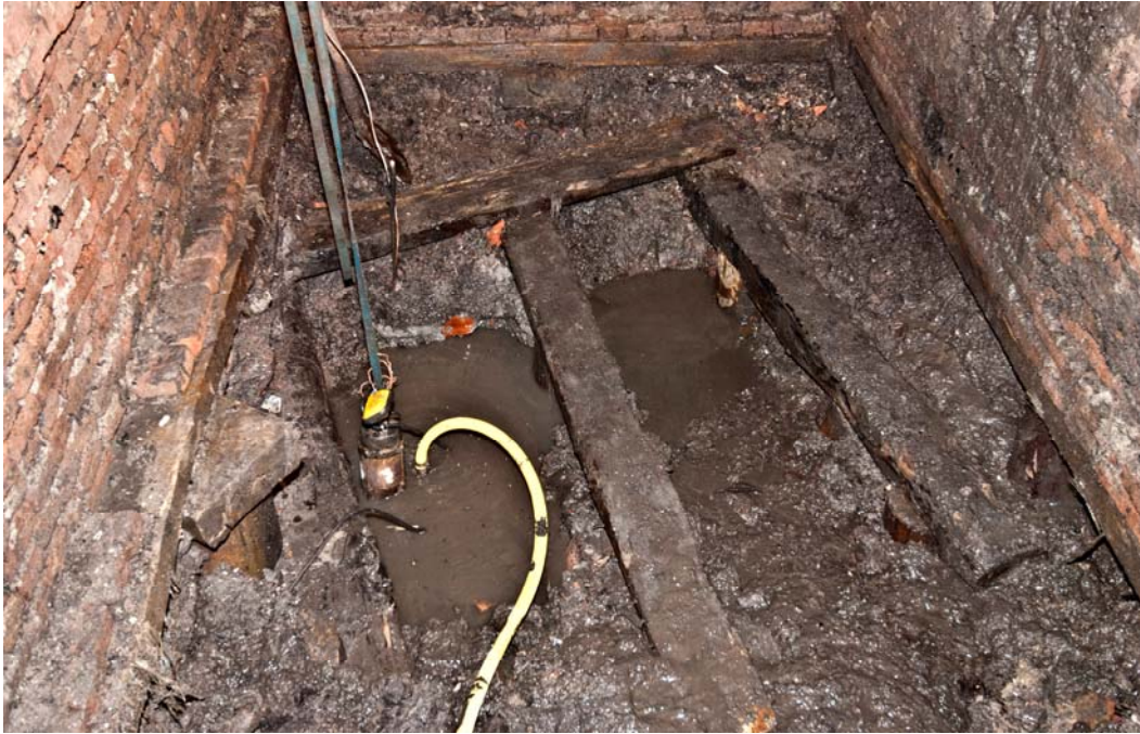
10 Overzicht van het raamwerk S 1 richting voorgevel
