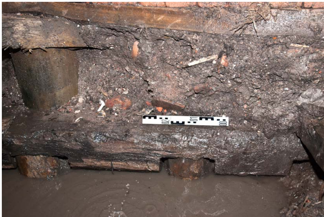
12 De 17de-eeuwse fundering (S 1, onder) met daarop een puinhoudende ophogingslaag (S 4) met daar boven de muurplaat van de fundering van Kazernestraat 14 uit 1903 (S 3)
