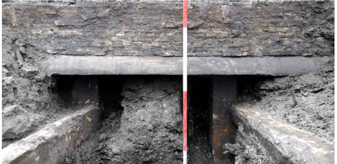
27 Muurwerk S 31 van het bakstenen pakhuis met een langshout van een gekliefde boomstam rustend op de funderingspalen van loods S 26
