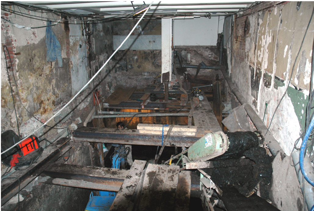
4 Keizersgracht 355 begane grond. Achter in de hoek, onder de opengebroken vloer, lag de (met een bouwlamp verlichte) beerput
