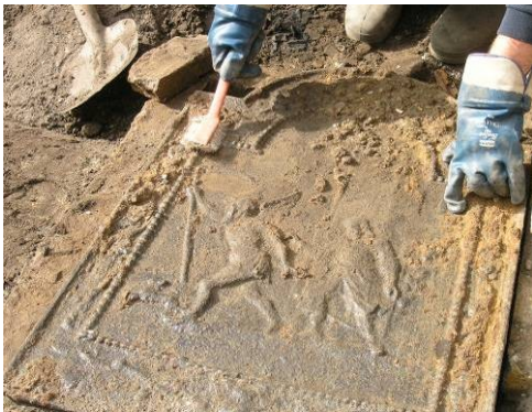
Afb.41-44 Onderzoek van waterkelder 4/5J, met een ijzeren haardplaat als deksel op het mangat
