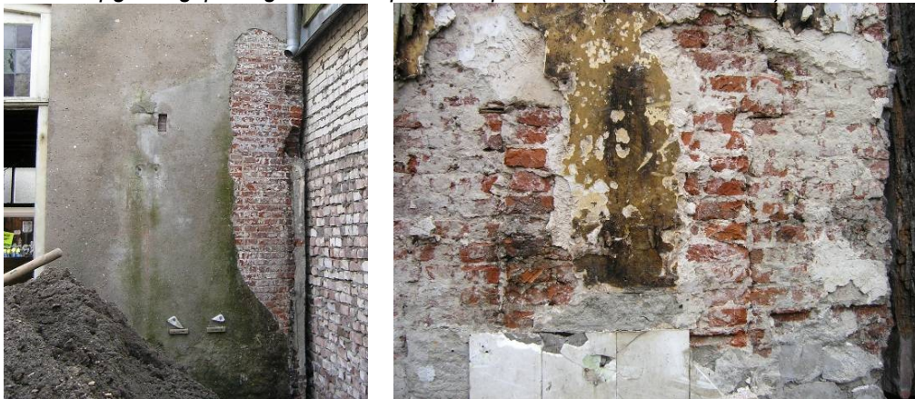
Afb.31a-b Detail van de achtergevel, met sporen van een dichtgezet venster aan de zuidkant
