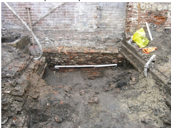
Afb.18a-b Het onderste muurwerk van 3B staat op de funderingen 2A en 2B (a.zuidmuur, b.noordmuur) en hierop is weer in de 19 de eeuw verder gebouwd
