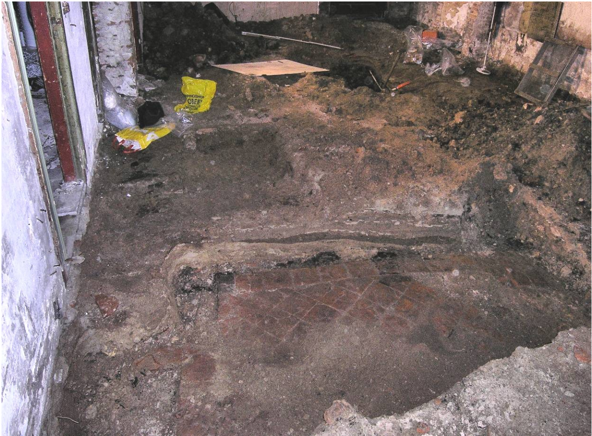
Afb.11 Plavuizenvloer 2F, vanuit het westen gezien
