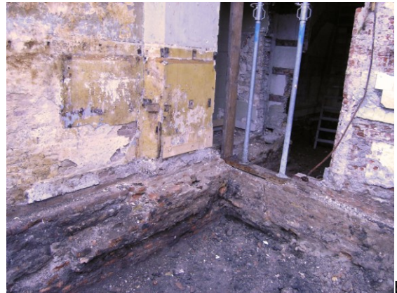
Afb.18a-b Het onderste muurwerk van 3B staat op de funderingen 2A en 2B (a.zuidmuur, b.noordmuur) en hierop is weer in de 19 de eeuw verder gebouwd
