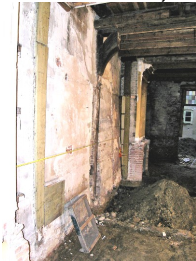
Afb.23a-b Eikenhouten gebint aan de zuidzijde, rechts aanzet van de kapjuk aan de voorste balklaag
