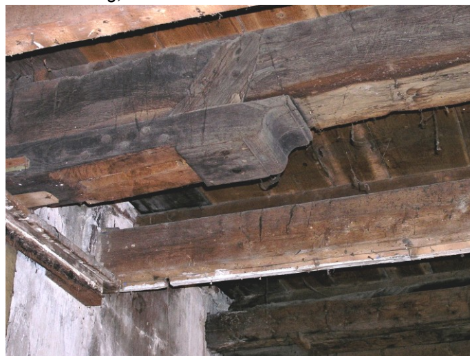
Afb.23a-b Eikenhouten gebint aan de zuidzijde, rechts aanzet van de kapjuk aan de voorste balklaag
