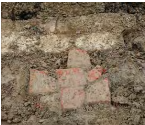
Afb. 6.28 Van het westelijke centrale blok van het dubbele kruisgewelf restte nog slechts de onderste funderingslaag (gezien in westelijke richting).
