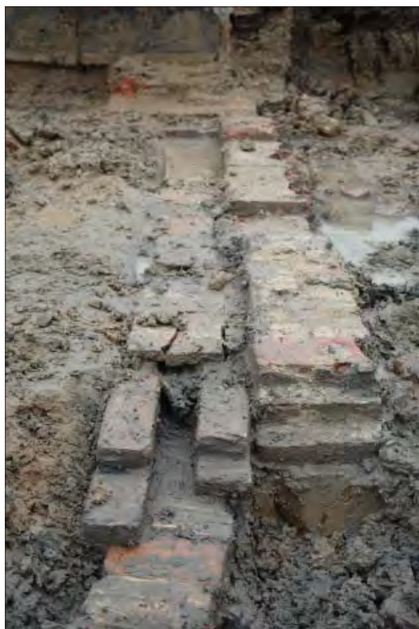
Afb. 6.13 Doorsnede door het noordelijke deel van de afvoergoot, gezien in westelijke richting. Rechts van de goot zijn de onderste drie steenlagen van de fundering van de noordelijke muur van de kaaskelder zichtbaar, vervaardigd van zeventiende-eeuwse stenen.
