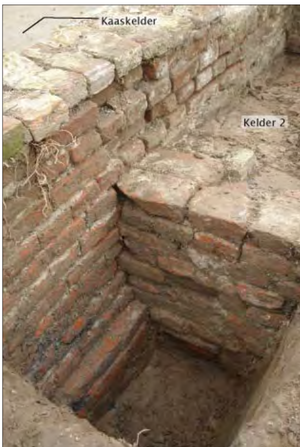
Afb. 6.20 De aansluiting van de noordmuur van kelder 2 (rechts) op de westmuur van de kaaskelder (links). De muur van kelder 2 grijpt 5 tot 10 cm in die van de kaaskelder, wat betekent dat beide gelijktijdig zijn aangelegd.
