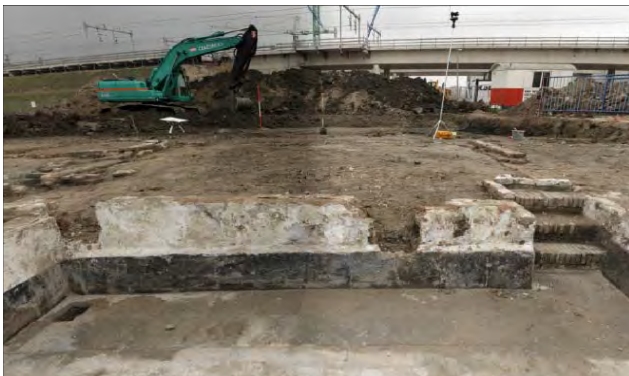
Afb. 10.4 De noordzijde van de kaaskelder met daarin de twee gaten ter verbetering van de afwatering, gezien in noordelijke richting.
