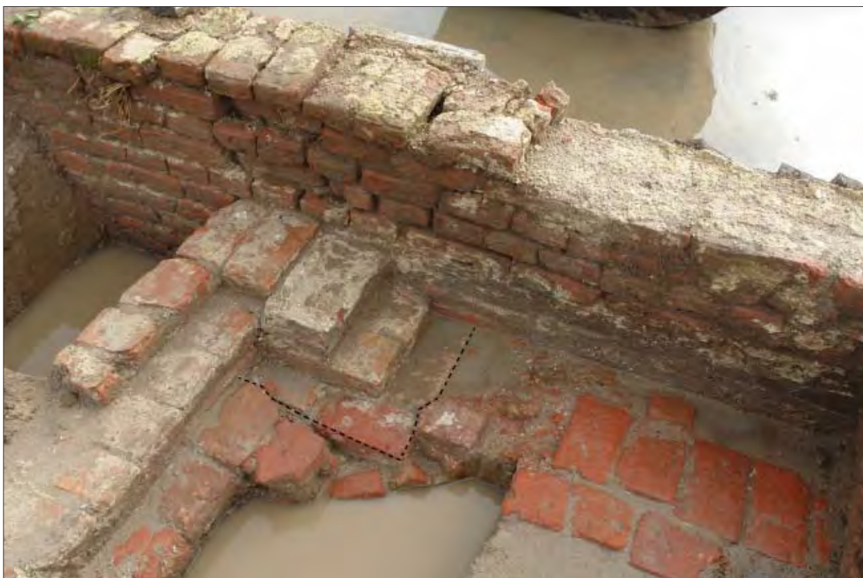
Afb. 6.25 Na het verwijderen van de keldervloer werd de fundering van het noordoostelijke hoekpunt van het dubbele kruisgewelf zichtbaar (gezien in noordoostelijke richting).
