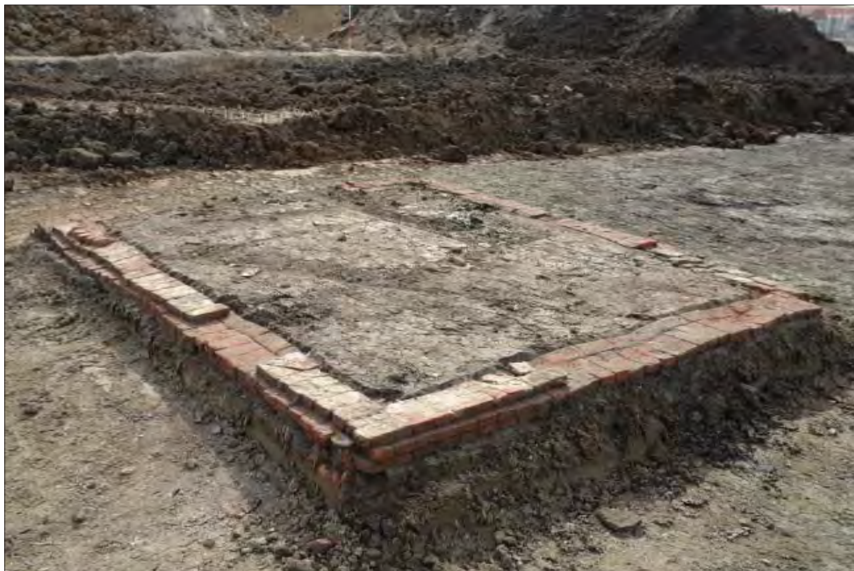
Afb. 6.45 Vlakfoto van de fundering van de 'duiventoren', richting het oosten.
