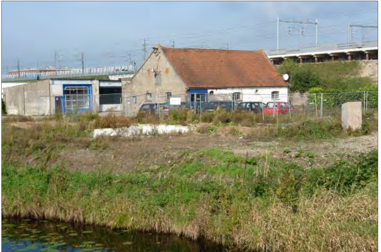
Afb. 8.14 De vermoedelijk vroeg-negentiende-eeuwse schuur vlak voor de sloop in 2010, gezien in noordwestelijke richting.
