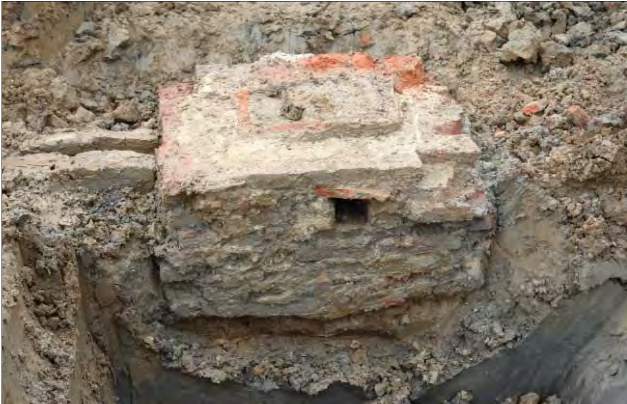
Afb. 6.14 De afvoerput in de noordwesthoek van de kaaskelder, gezien in westelijke richting.
