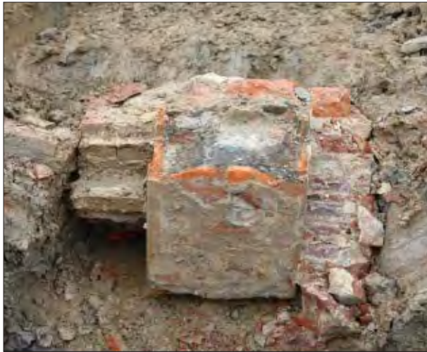
Afb. 6.16 Gedeeltelijk gedemonteerde afvoergoot, gezien in westelijke richting. De oostzijde van de afvoerput is verwijderd, waardoor de (in een latere fase) met mortel volgestorte binnenzijde van de afvoerput zichtbaar is geworden.
