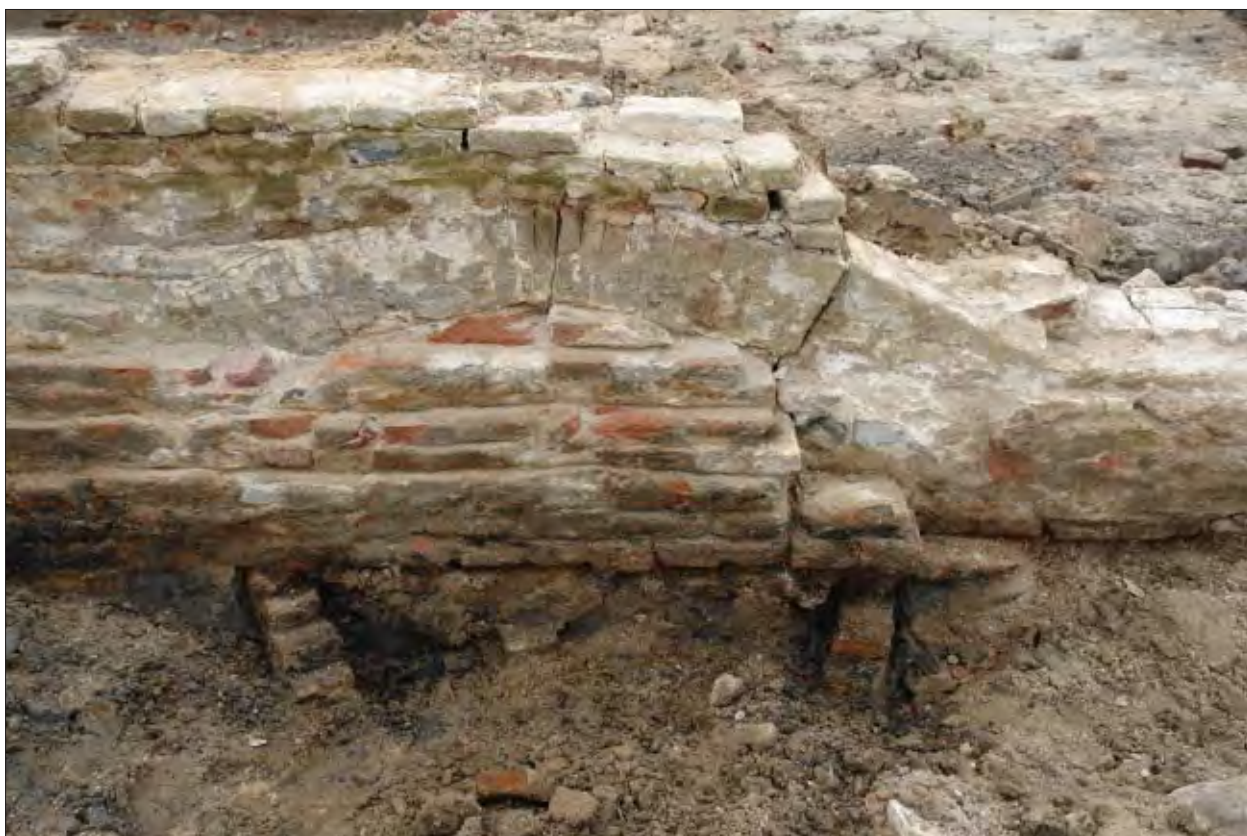
Afb. 9.6 Detail van de noordelijke stalmuur van de boerderij uit 1916 met een spaarboog over beerput BP02 heen, gezien in zuidelijke richting.
