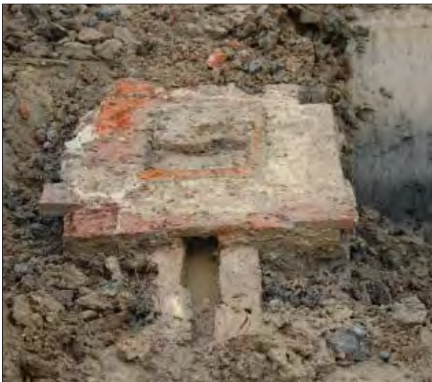
Afb. 6.15 De afvoerput in de noordwesthoek van de kaaskelder, gezien in noordelijke richting.
