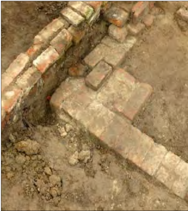
Afb. 6.26 De onderste laag van de fundering van het noordwestelijke hoekpunt van het dubbele kruisgewelf in kelder 2 (gezien in noordoostelijke richting). (bron: http://www.bumos.nl/coehoorn )
