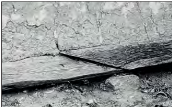
Afb. 16.7 Schuine las in een stijlvoetplaat (uit Berends 1996, 95).
