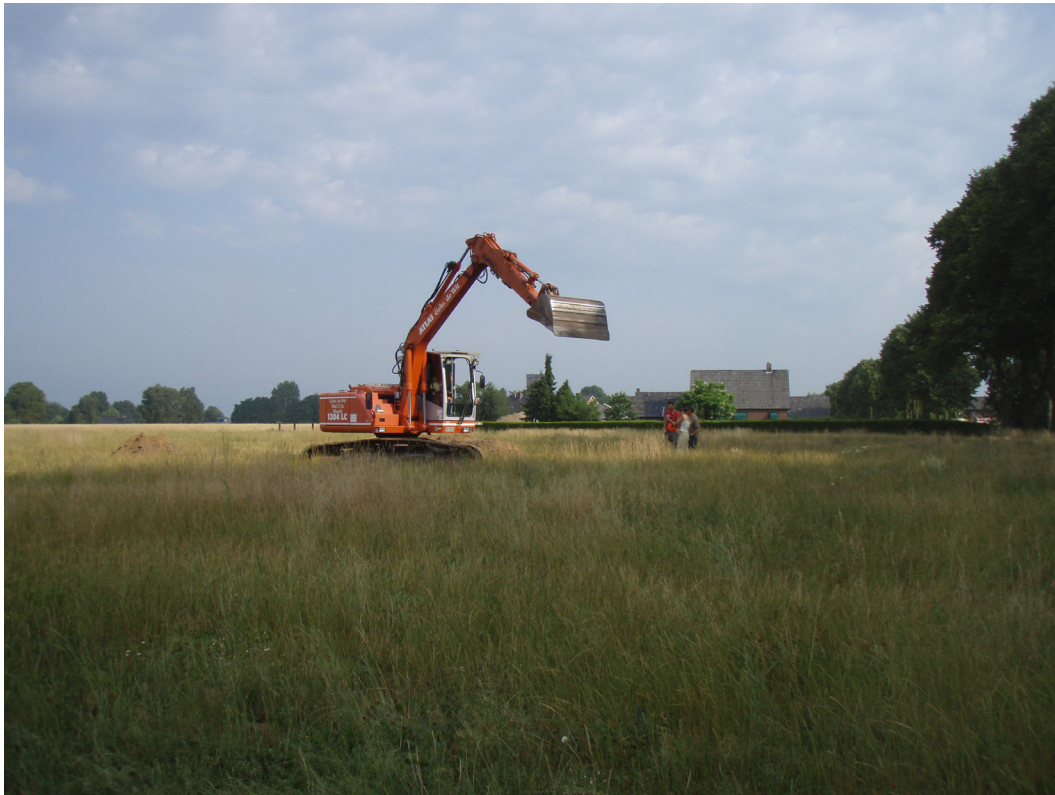
Afb. 3 Het graafwerk langs de Koksgoedweg begint.
