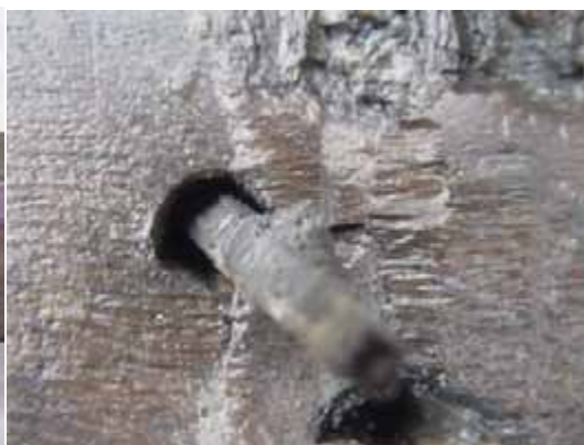
Fig. 18.36 Een voorgeboord spijkergat.
