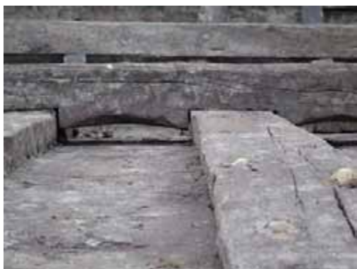
Fig. 18.45 Het intensief bewerkte zaathout
