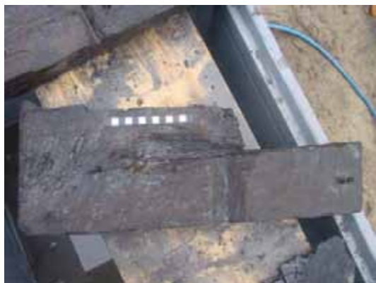
Fig. 18.31 Bijlsporen op de onderkant van een spant.
