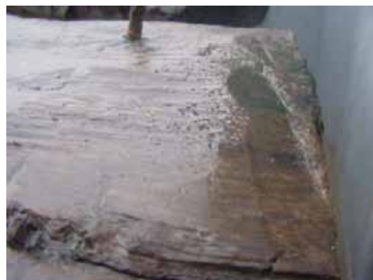
Fig. 18.32 Het uiteinde van een bijgewerkt spant.
