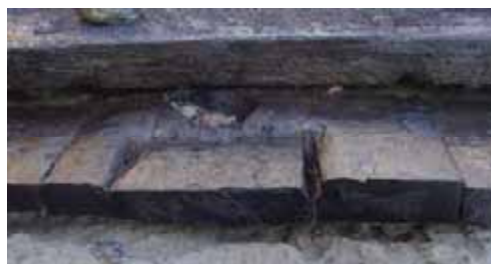
Fig. 18.17 reparatie in een vlakgang.
