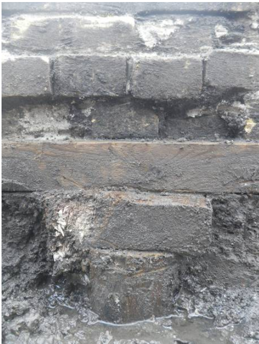
Afb. 11. Rotterdamse funderingsmethode S10.
