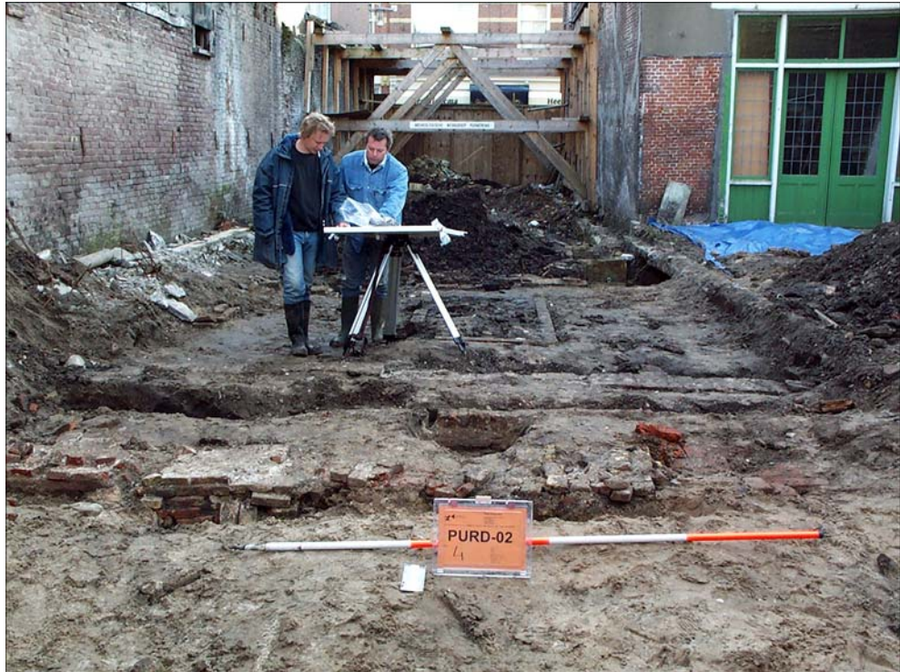
Afb. 3 Het voorterrein met daarop de gestutte belendende panden aan de Padjedijk.
