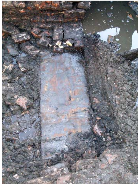
Afb. 10 Fundering van de grutterij.
