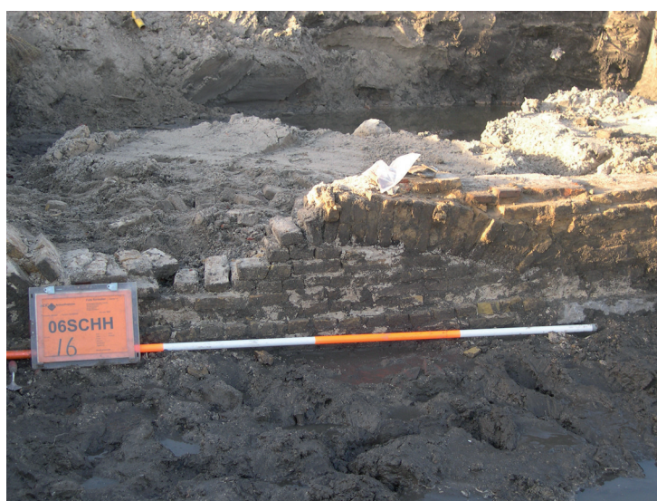
Afb. 7 Dichtgezette spaarboogfundering.
