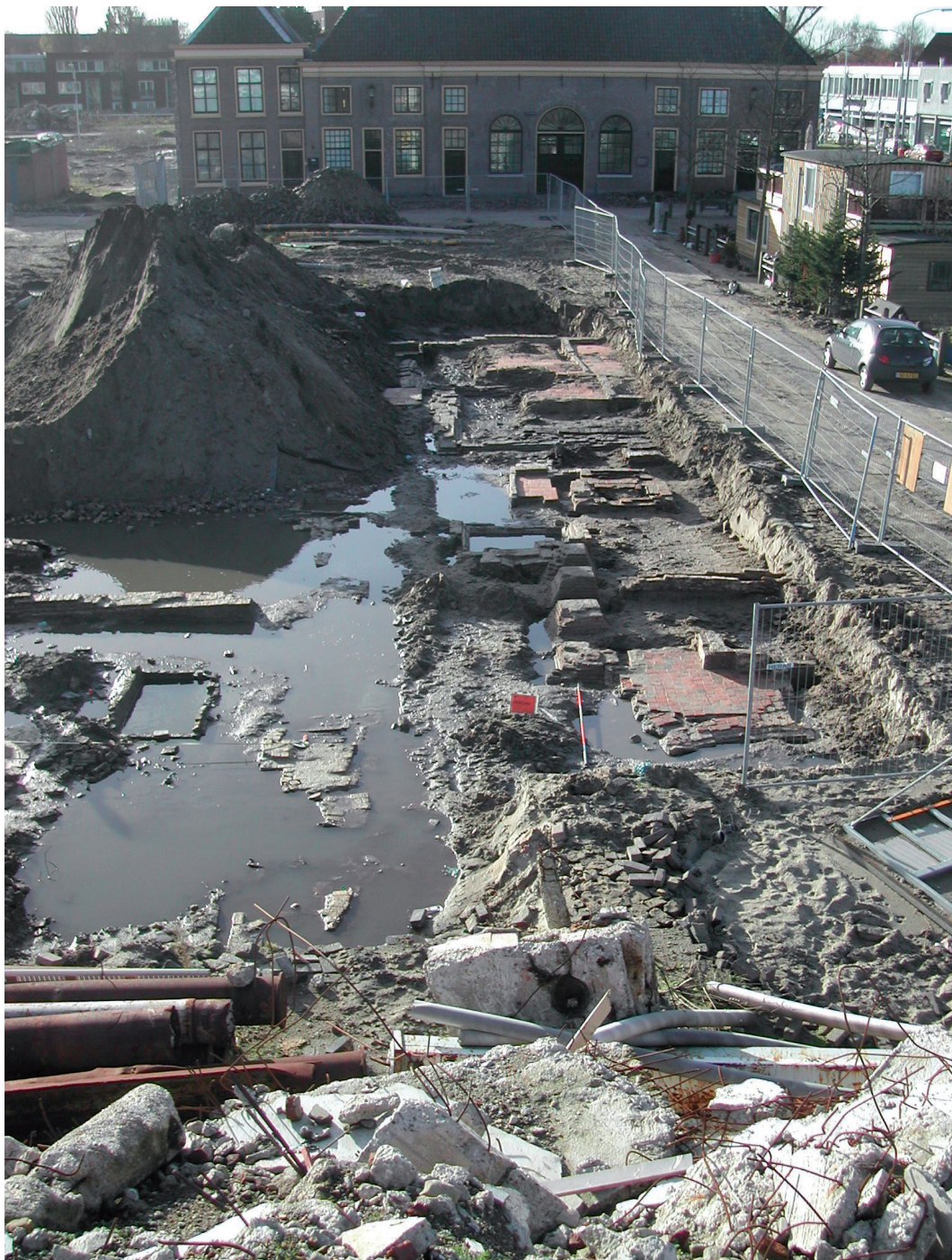
Afb. 16 De poeren en kelders gezien vanuit het noorden.
