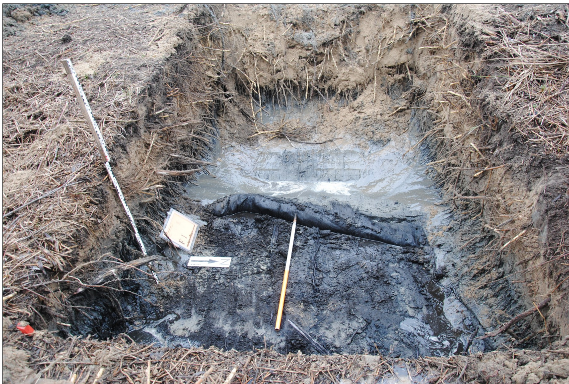
Afbeelding 4. Vergraven veen met daarop saneringsdoek en opgebracht schoon zand. Foto richting westen.
