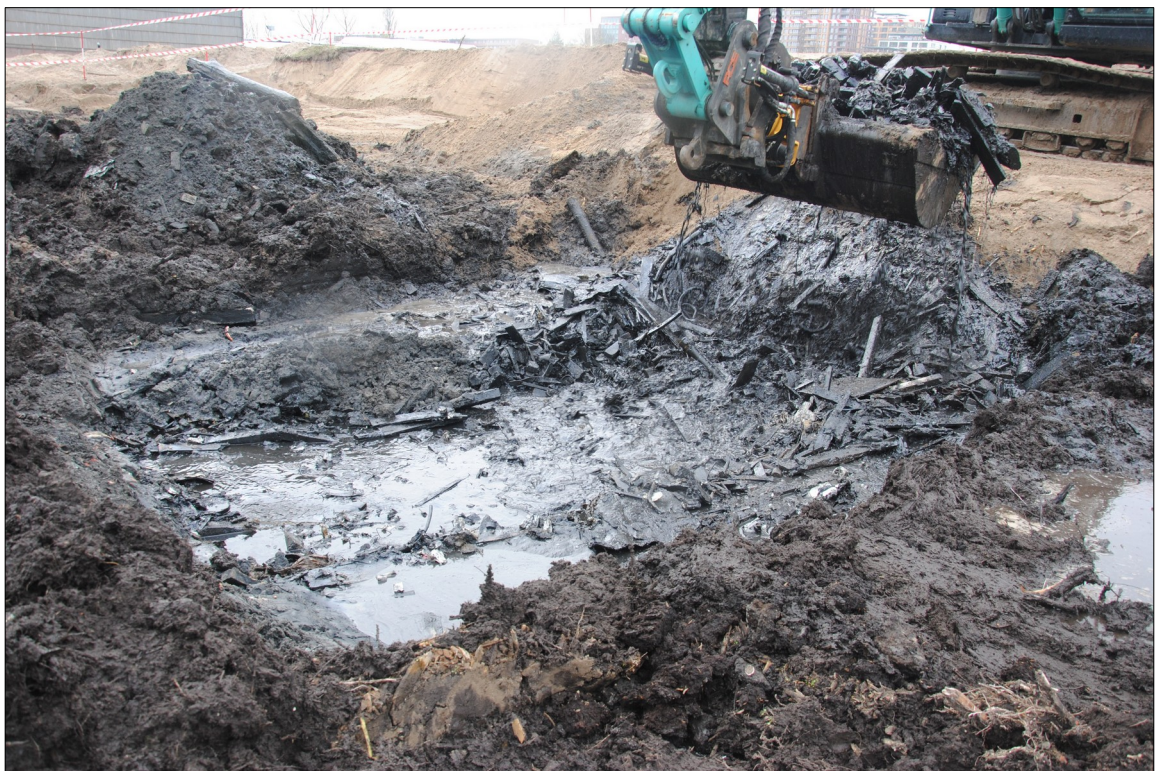
Afbeelding 12. Puin, hout en bagger in het noordelijke deel van werkput 11.
