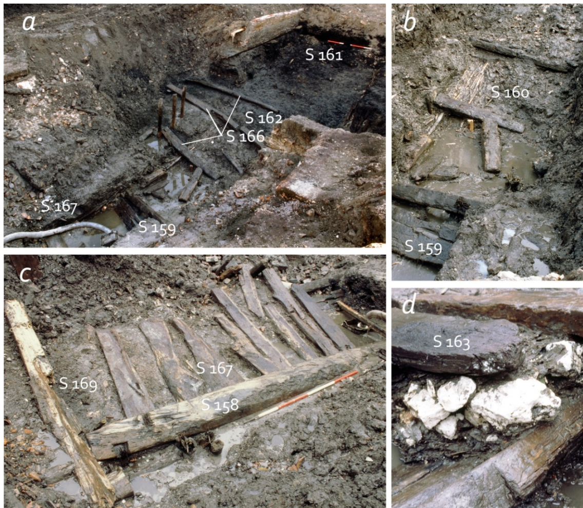
17 Hellingconstructies op perceel I, a) overzicht waarbij plankier S 167 nog niet is ontgraven. b) de eikenhouten liggers (S 166) liggen direct op het rijshout S 160. c) het plankier aan de voet van de helling (S 167) met de balkconstructie ten (S 158 en S 169) behoeve van de latere landwinning d) grote brokken krijt (S 163) liggen tussen het hout van de helling constructie
