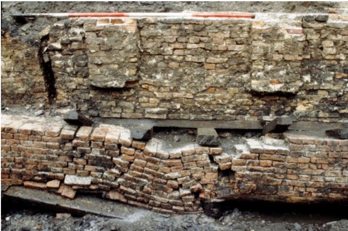
36 De fundering van de nieuwbouw op perceel II (S 132) werd zonder te onderheien geplaatst op de afgesloopte bouwmuur van de oorspronkelijke bebouwing (S 127)
