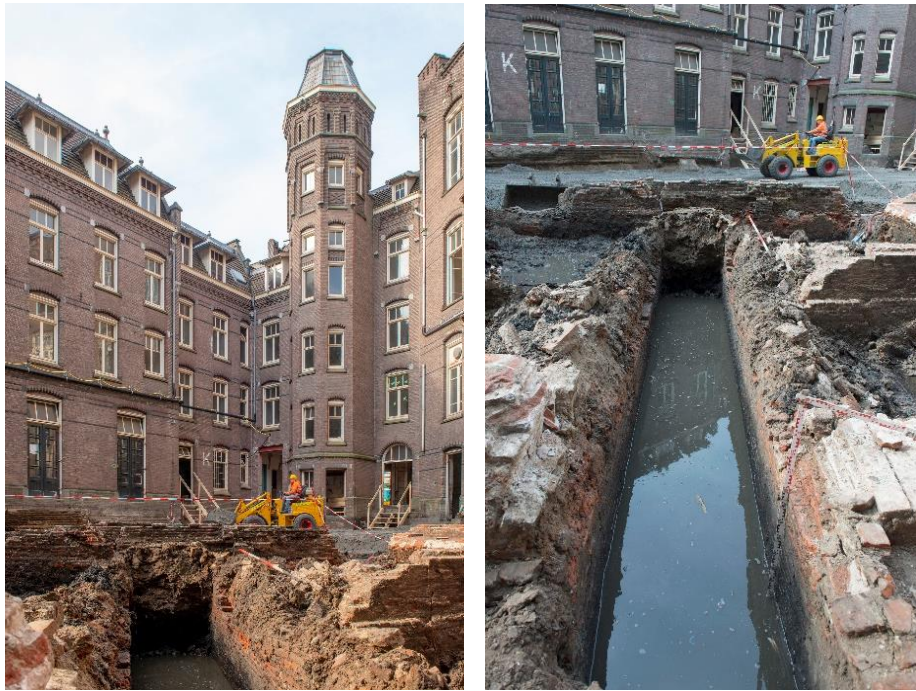
3.33 Riool S 112 na verwijdering van het gewelf, gezien naar het zuiden
