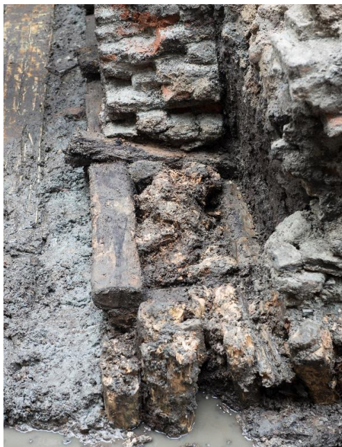
3.16 Links de roosterfundering onder muur S 145 en rechts een tekening van dit funderingsprincipe
