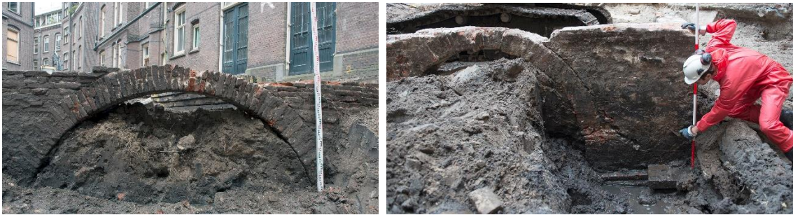
3.35 Muur S 107 met grondboog, gezien richting oosten
