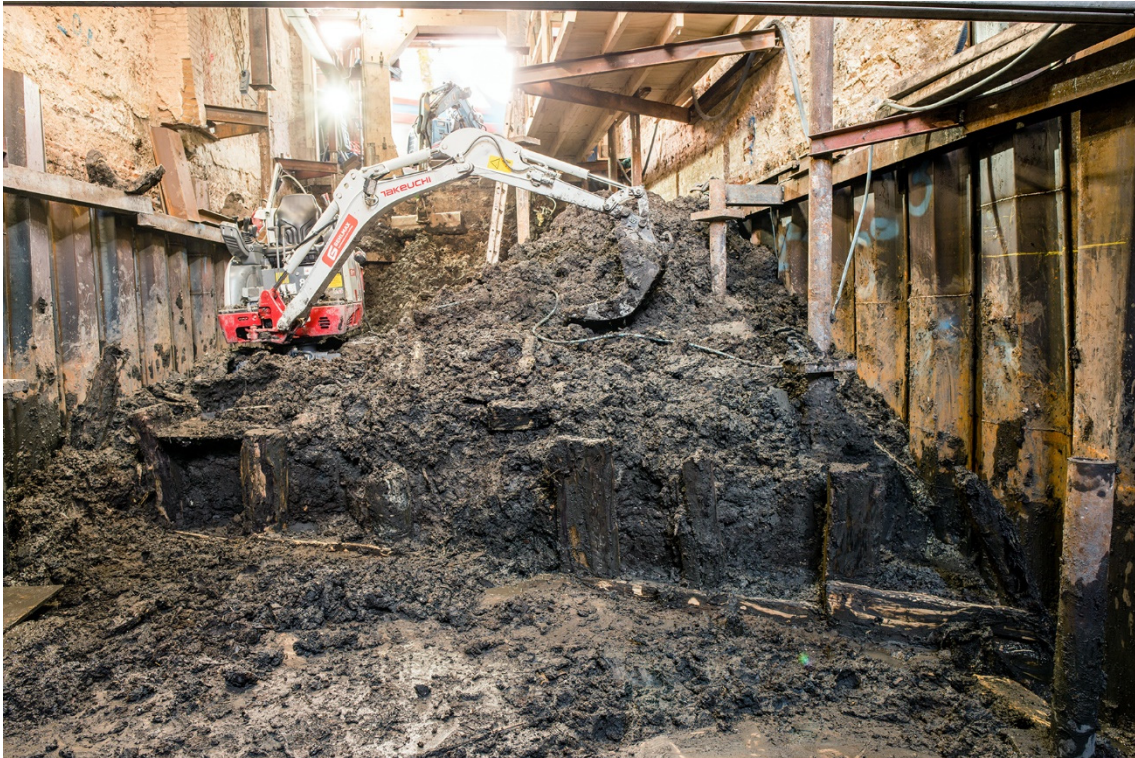
15 Het archeologisch onderzoek als onderdeel van de kelderontgraving met de binnenzijde van de beschoeiing (S 8) van het bastion uit 1592-1596, gezien naar de Nieuwe Herengracht
