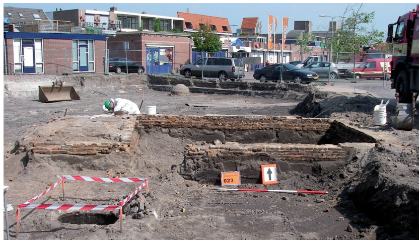
Afbeelding 22: de oorspronkelijke achtergevel van pand M50-zuidzijde (S 55, links op de foto) en de aanbouw uit fase 6 (S 58, rechts op de foto). De pijl wijst richting het noorden
