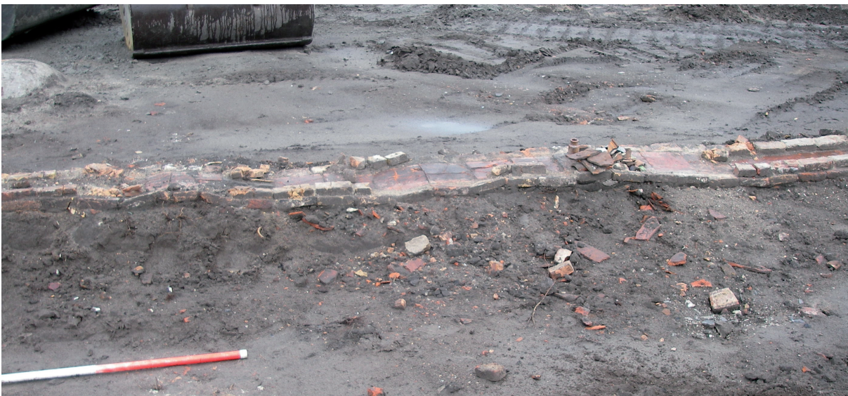
Afbeelding 21: goot voor de afvoer van regenwater (S 164). De wanden van de goot waren opgetrokken in halfsteens metselwerk. De bodem van de goot was voorzien van plavuizen.
