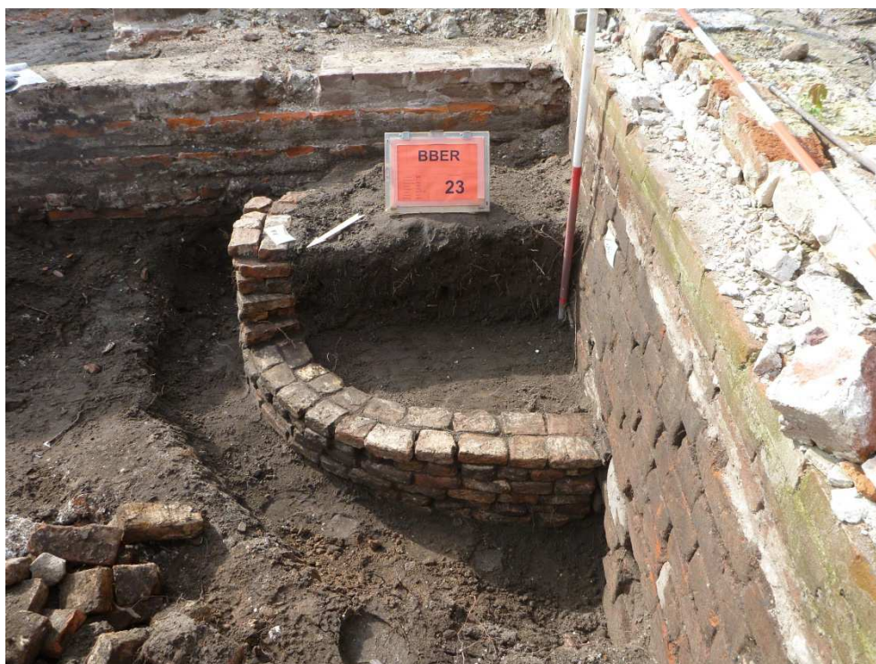
Figuur 20. Halfronde mogelijke beerput (F61) tegen de stadsmuur (rechts, F63) en doorsneden door fundament F35 (achtergrond) in put II, vlak 2.
