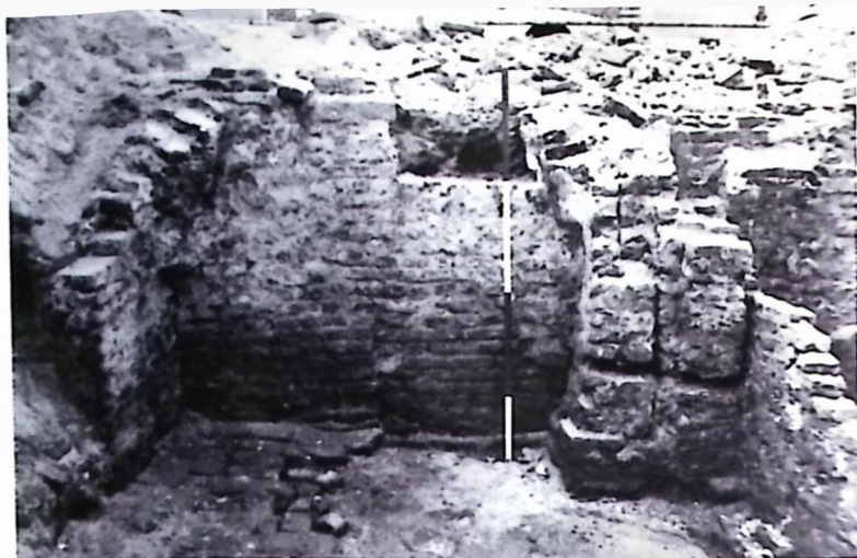
De middenkelder van het hoekpand. De aanzetten van het kruisgewelf zijn nog zichtbaar.
