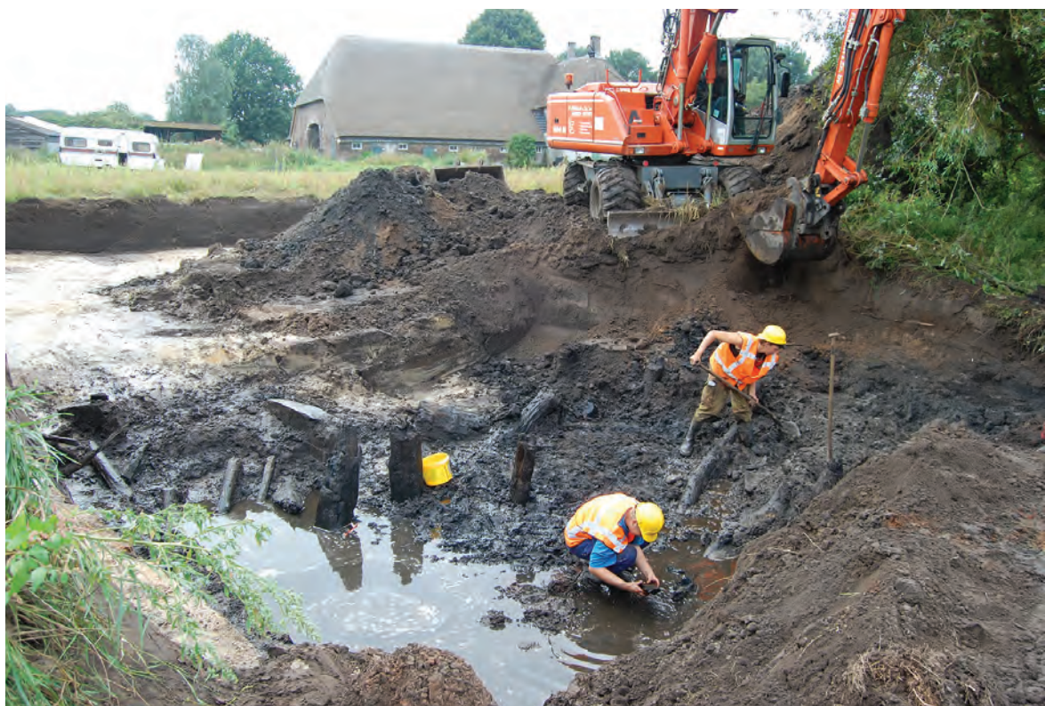
Afb. 8.3 De houten fundering van de watermolen tijdens het onderzoek in 2008.
