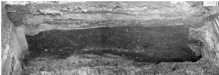
Afb. 4 Profiel onder de vloeren van gebouw 1. Zichtbaar is de zwarte ophogingsgrond met de grondverbetering die werd aangebracht voor de aanleg van de fundering.
