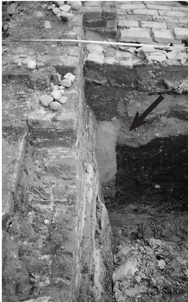
Afb. 13 Fundering van gebouw 1 met daaronder de grondverbetering van schoon zand, ingegraven in de zwarte ophogingsgrond.
