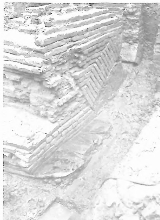
Afb. 22 Het stuurriemblad (tekening) dat samen met enkele planken als funderingsplaat van een van de pijlers van een spaarboeg (foto) van het Minderbroedersklooster in Dordrecht is gebruikt.
