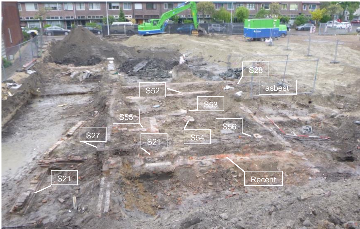
Figuur 13: Een overzicht van de muurfunderingen en goten aan de noordkant van het plangebied in WP9 en WP5. De vindplaats van enkele recentere asbestpijpjes is middels hekken afgezet en aangeduid met 'asbest' in de figuur.
