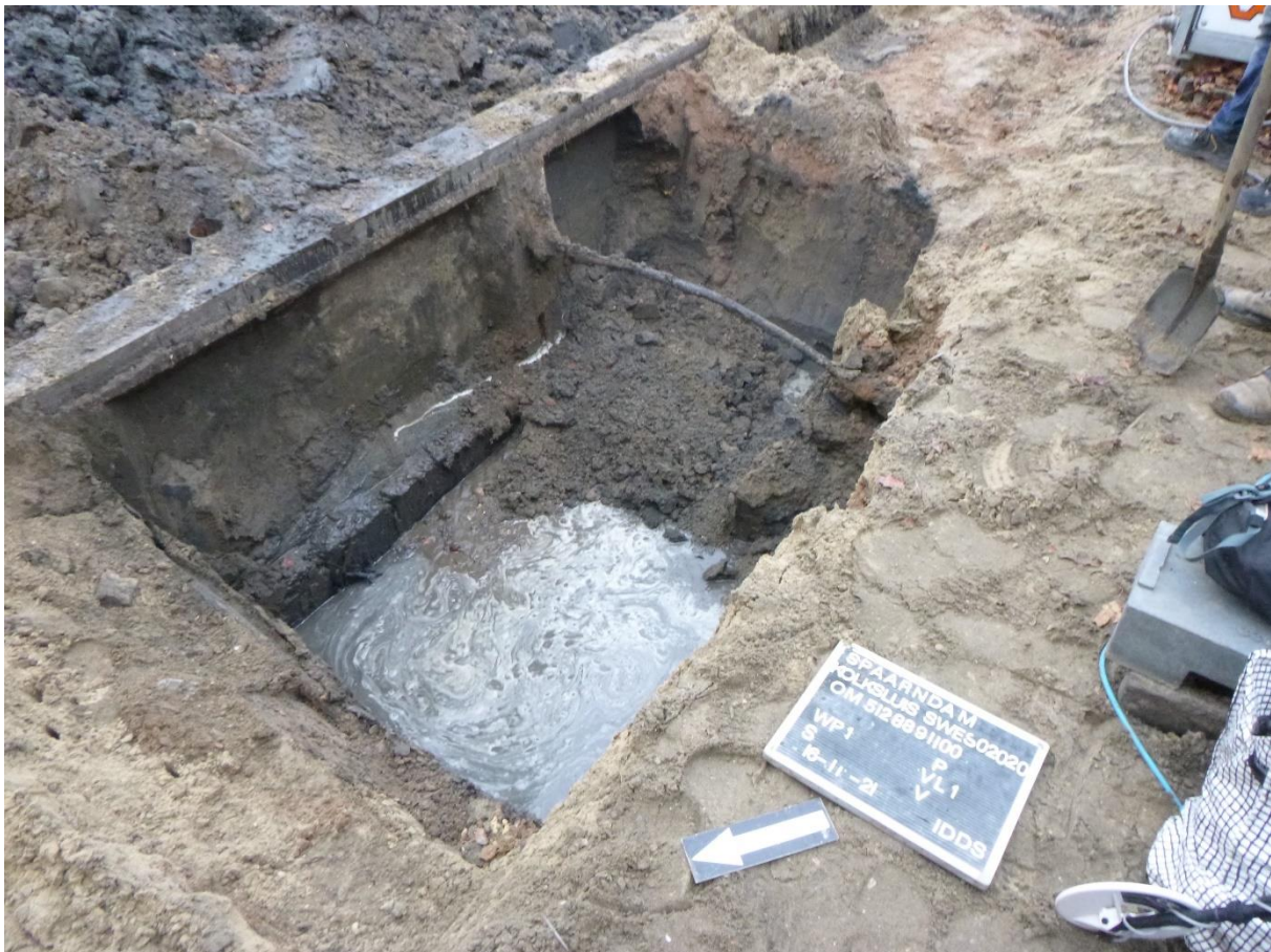
Figuur 4: De situatie aan de zuidzijde van de Westkolk met de betonnen opbouw van de kade.
