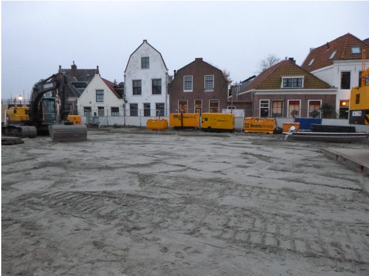
Figuur 1: Het plangebied voor aanvang van de werkzaamheden. Op de voorgrond de gedempte Kolksluis. De huizen op de achtergrond staan aan de Oostkolk. De foto is richting het oosten gemaakt.
