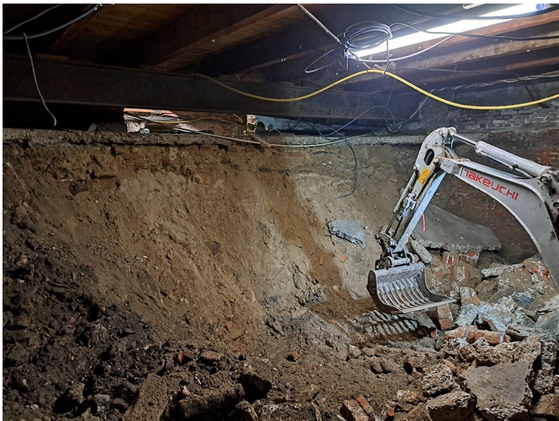
1 De zand en puinvulling van kelderruimte 2 ter hoogte van de voormalige binnenplaats waar in 1920 de glazen overkapping werd gerealiseerd
