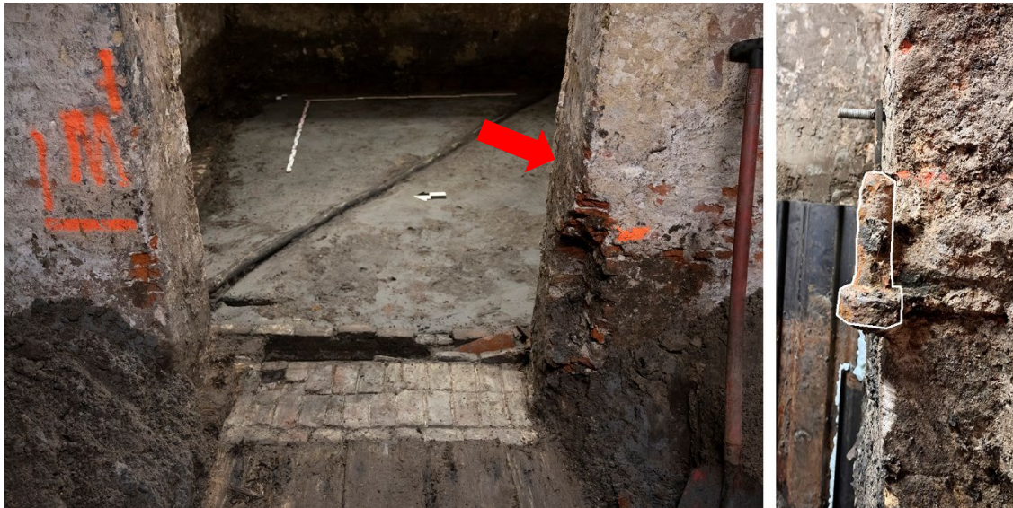
19 Doorzicht vanuit ruimte 3 naar 3a met op de voorgrond de plankenvloer S 2 die aansluit op de doorgang in het 2,5 steens brede metselwerk van de tussenmuur S 31. De rode pijl geeft de locatie aan van de duim (foto rechts) die net om het hoekje in het metselwerk was bevestigd
