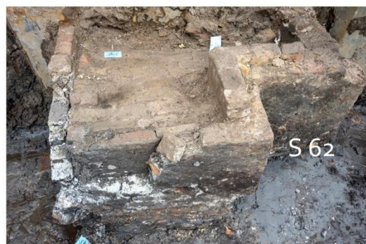
34 Foeliedwardsstraat 36 en 38, vlak 2. De gemene muur s 16 was gefundeerd op langshout en palen (S 76). Door verzakking waren de muur en langshout over de paalkoppen heen gezakt. In de eerste fase waren in beide panden een kelder aanwezig (S 85 en S 62)
