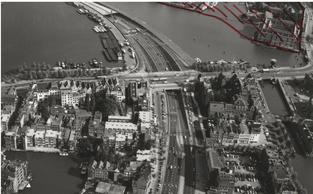
5 De zuidelijke toegang tot de IJtunnel in 1981 met links de Foeliestraat en rechts de Nieuwe Foeliestraat, de nieuwe begrenzing van het bouwblok tussen Rapenburg en de Foeliedwardsstraat (Stadsarchief Amsterdam, B00000035967)
