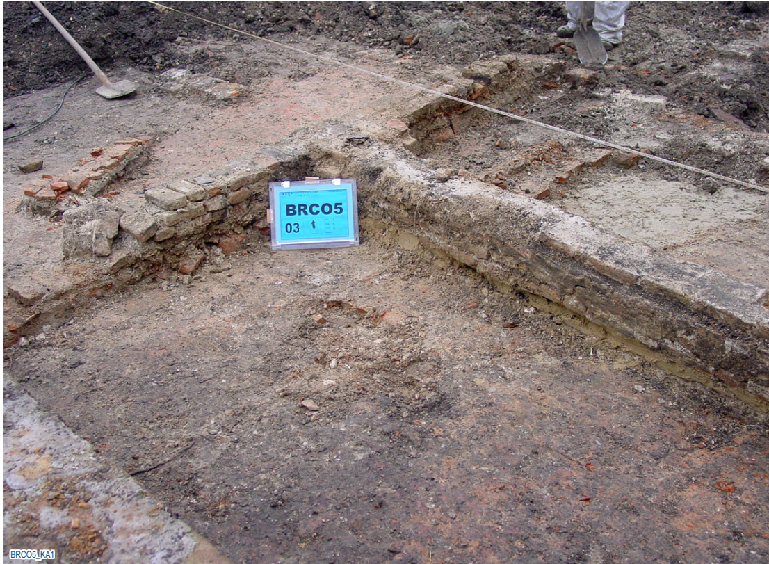
Figuur 7. Fundering op zandlaag/oude vloer.
