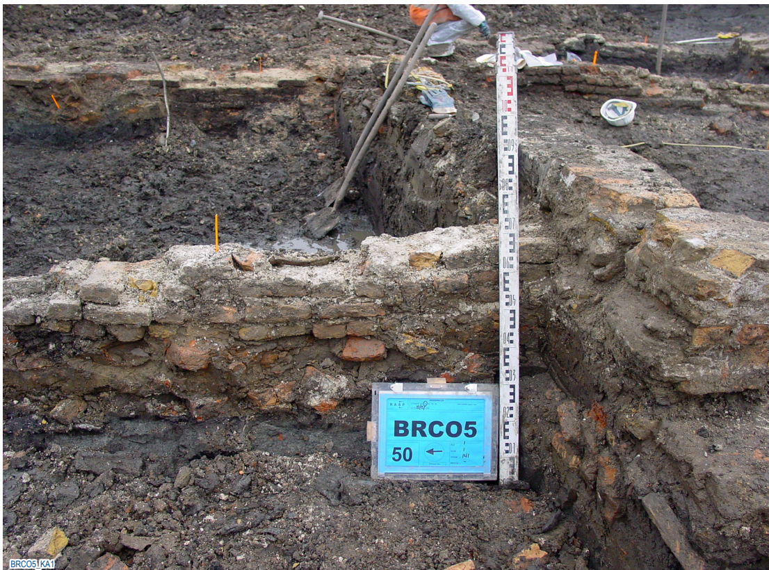
Figuur 8. Slordig metselwerk (o.a. spoor 141).
