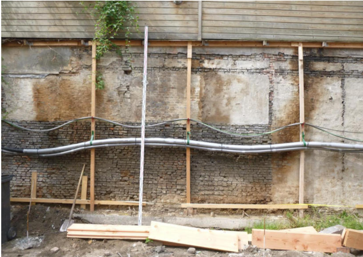
Figuur 7: Zijaanzicht pand naast werkput 6. De rommelige bouw wijst erop dat het vermoedelijk een binnenmuur betreft. Tevens is doorslag van de stookplaats van het buurpand te zien.
