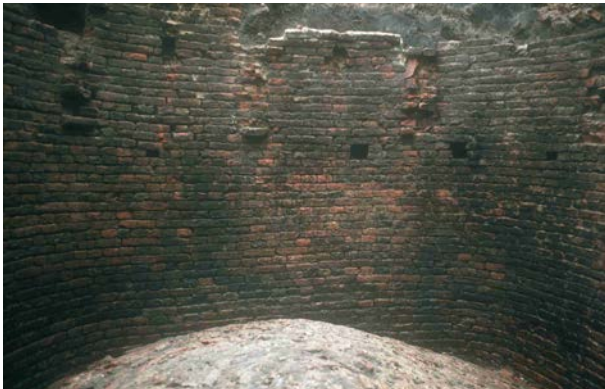
Afb. 60 Formeelgaten en uitstulpingen aan de binnenzijde van beerput F67, richting het zuiden.
