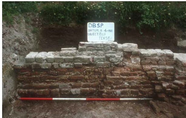
Afb. 52 Muur F10 tegen poeren F9, richting het zuiden.
