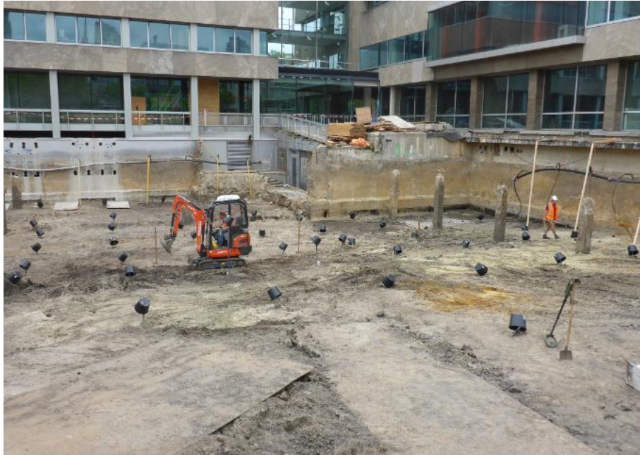
Afb. 2.13 Het onderzoeksg gebied na het uitgraven van de bouwput (werkput 2). De ijzeren pennen van oude boorpalen zijn uit veiligheidsoverwegingen afgedekt met zwarte emmers. Foto richting het zuiden (foto BAAC).
