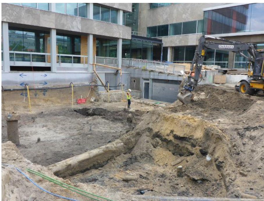
Afb. 2.14 Aanleg van het vlak in werkput 2 (foto BAAC).
