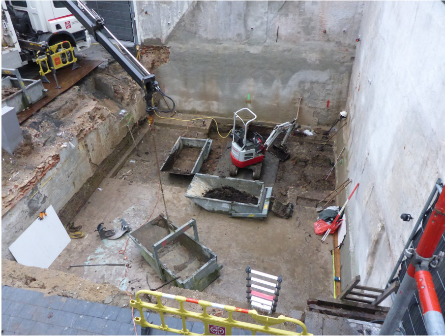
Afb. 1.1 Een impressie van de werkzaamheden. Foto genomen richting het oosten (bron: BAAC).
