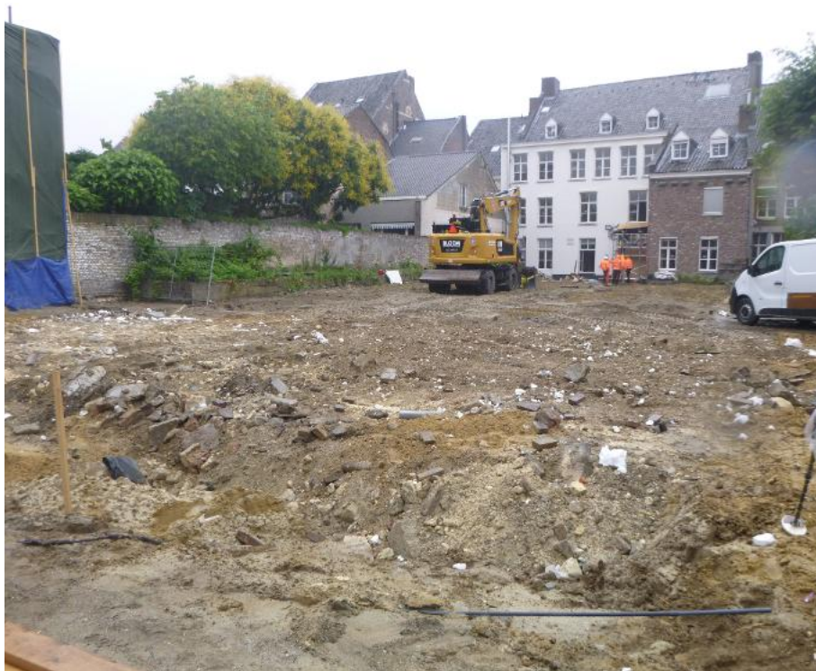
Afb. 1.2 Het plangebied voor aanvang van de werkzaamheden.
